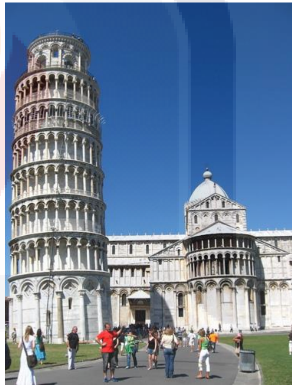
Imagen 1.- Torre de Pisa afectada por hundimientos diferenciales del terreno en que se desplanta. (Anónimo)
