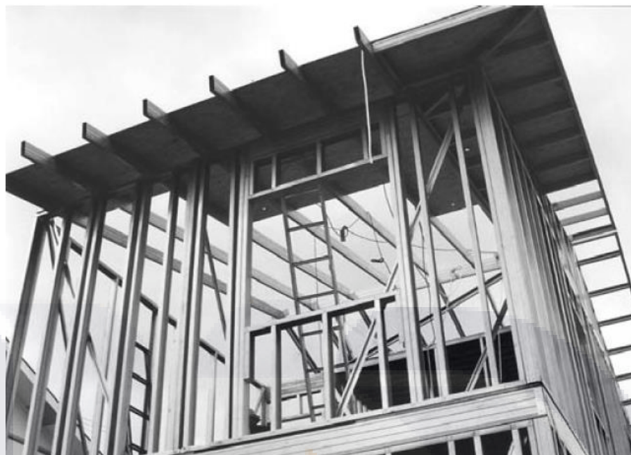
Imagen 2.- Vivienda con Estructura de Perfiles de Acero Rolado en Frio (Sarmanho & Moraes, 2007)
