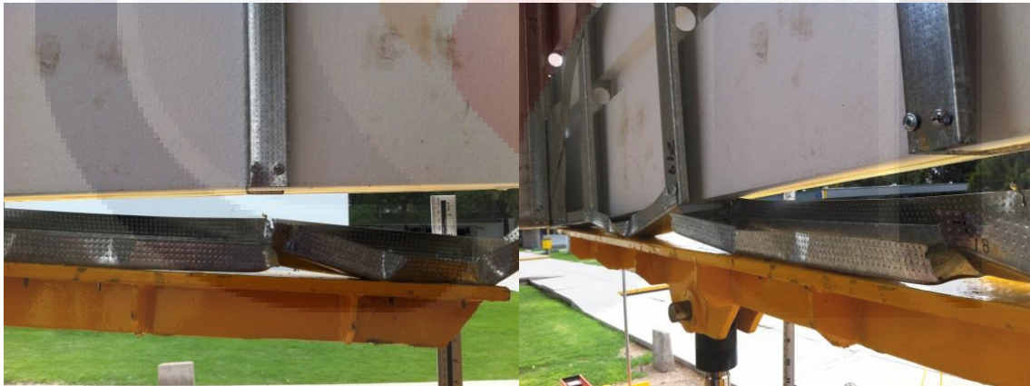
Imagen 68 e Imagen 69.- Falla inesperada de la conexión inferior de los studs con los tracks por deslizamiento del bloque de cortante en la sección crítica.
