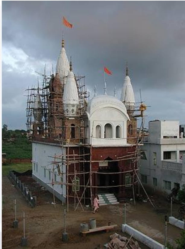
Fotografía 13 Construcción de un templo de la misión SCSM en India
