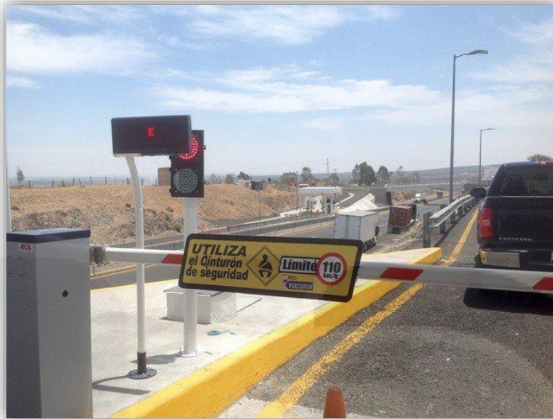
Conexión con la autopista
