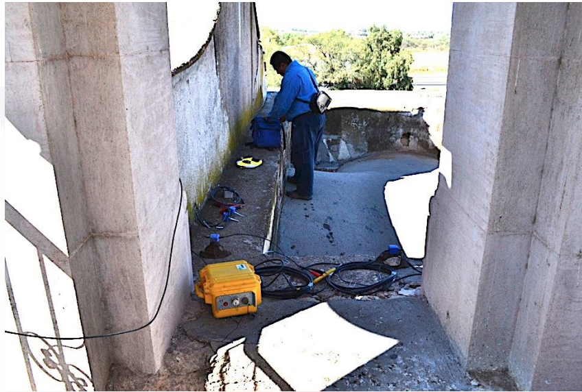
Fig.57: Preparación y conexión del equipo de medición para toma de vibraciones en muro.
