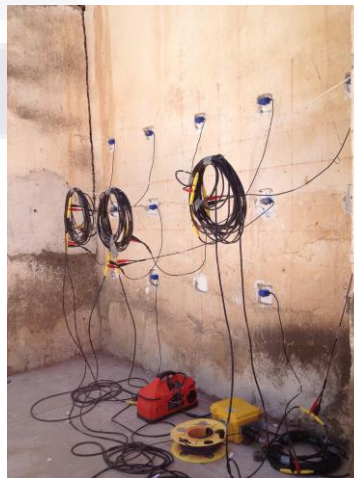
Fig.76: Instrumentación del muro de la fachada oriente para la obtención de las propiedades del muro de adobe.
