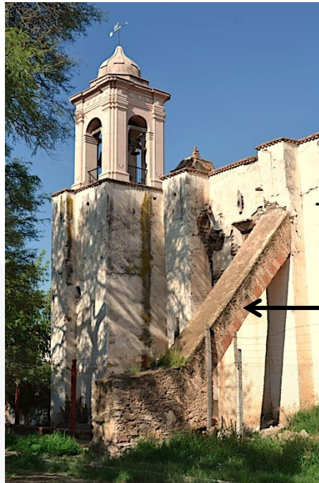
Fig.25: Contrafuerte de la fachada oriente formado a base de mampostería de piedra en basamento y en el cuerpo a base de mezcla de materiales de piedra y algunos de barro.
