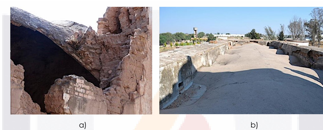
Fig.22: Bóveda de cañón 2 capas de cuña de barro correspondiente al granero y capa de concreto armado sobre bóveda original de la capilla.
