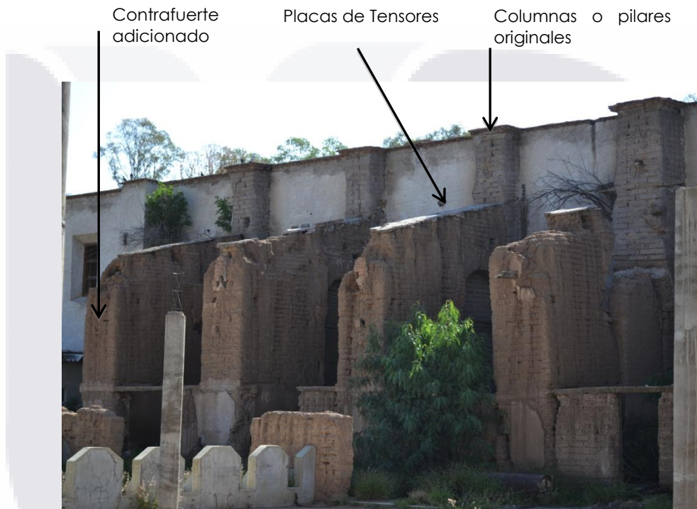
Fig.24: Contrafuertes a base de bloques de adobe adosados a los pilares de los muros construidos anteriormente, formando arcos tipo botarel se observa el color en el cambio de los materiales utilizados en distintas etapas.
