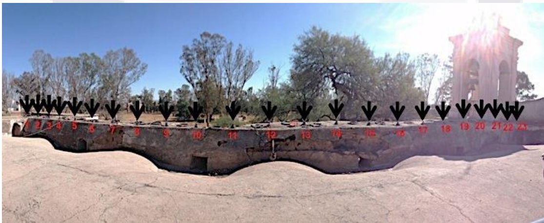
Fig.56: Distribución de geófonos en el muro de la fachada oriente.
