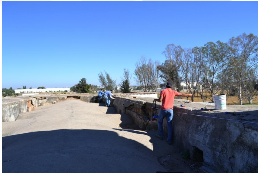
Fig.55: Medición para la colocación de los geófonos en muro de fachada oriente.
