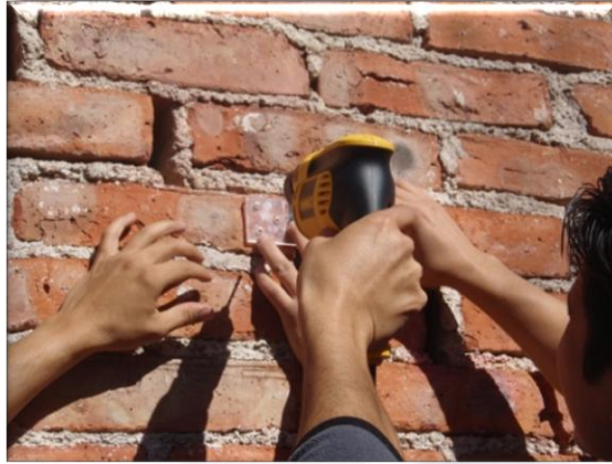
Figura 12. Colocación del fisurómetro
