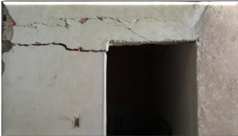
Figura 68. Muro 45 planta alta
