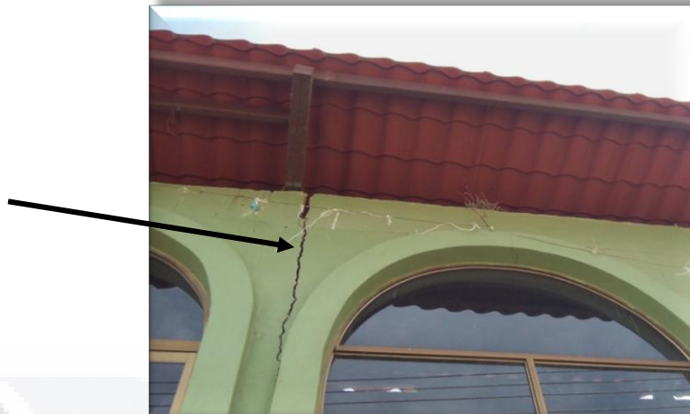
Figura 53. Muro 12 de planta alta. Vista exterior
