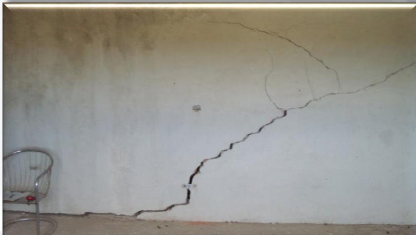
Figura 56. Muro 30 planta alta
