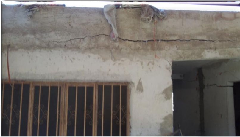
Figura 62. Muro 33 y 34 planta alta.
