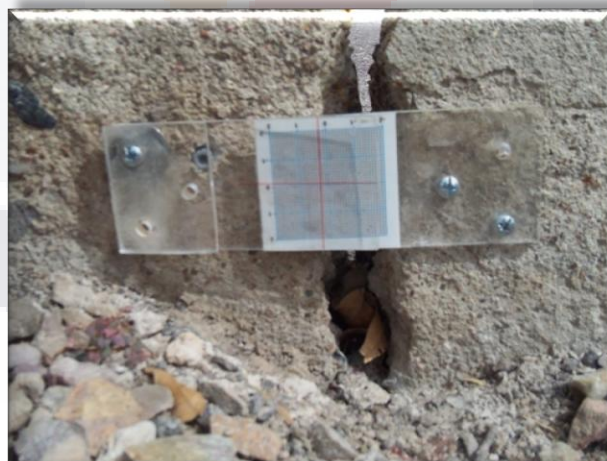
Figura 32 Fisurómetro. PL-17
