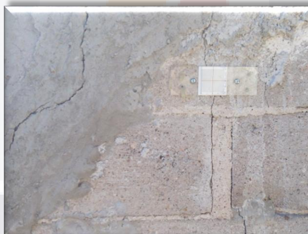
Figura 26. Fisurómetro PL-11
