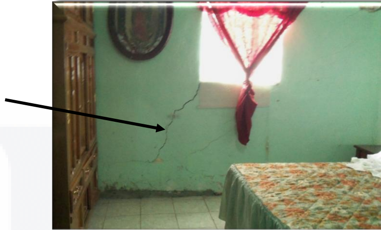
Figura 48. Muro 10 de planta baja. Vista interna
