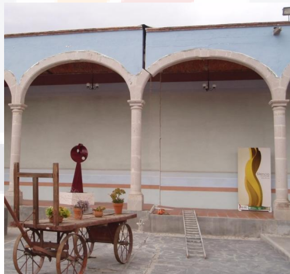
Figura 17. Arcos en lado norte
