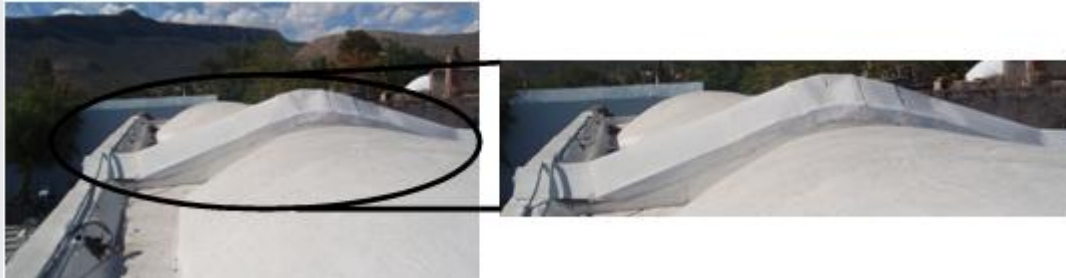
Figura 21. Tapajuntas en azotea, lado norte.
