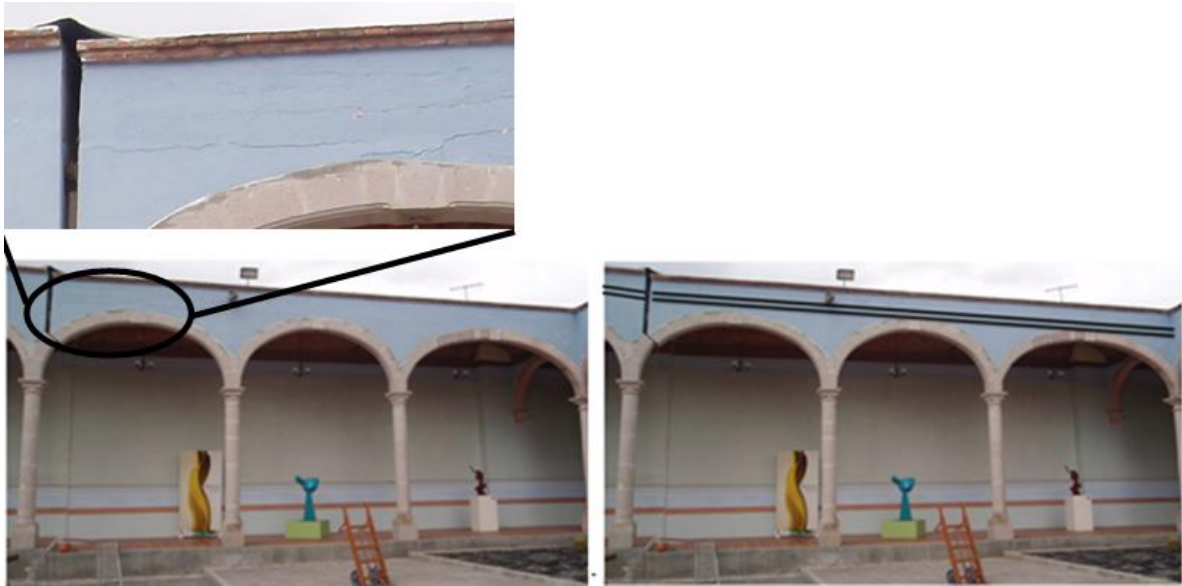
Figura 65. Vista frontal de los arcos sobre las columnas norte.
