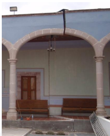
Figura 22. Bóveda, muro y arco sur.
