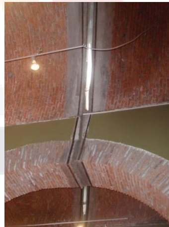
Figura 28. Junta fría en bóveda, sala de exhibición principal.
