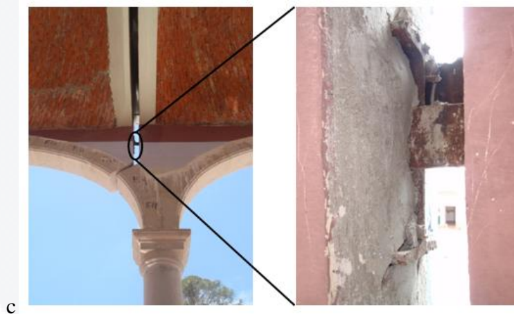
Figura 67. Se muestra la junta fría en el arco norte.
