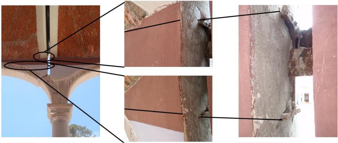
Figura 66. Vista frontal de la junta fría en el arco norte viendo por el pasillo.
