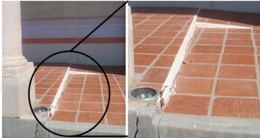
Figura 33. Simulación de escalón por cambio a desnivel provocado por la falla en arco norte
