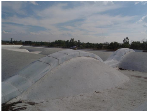
Figura 29. Tapajuntas en bóvedas, sala de exhibición principal.
