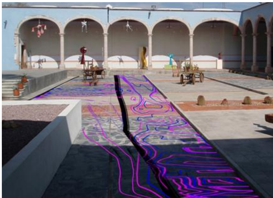
Figura 40. Zona de topografía más detallada, observando curvas de nivel (azul = 1mm. y magenta =0.5mm.) y trayectoria de falla.
