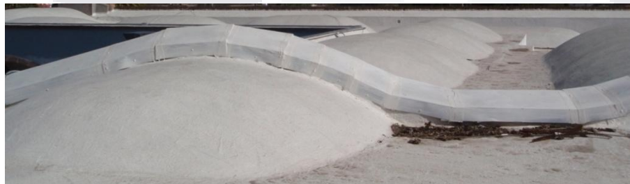
Figura 26. Tapajuntas en pasillo sur.
