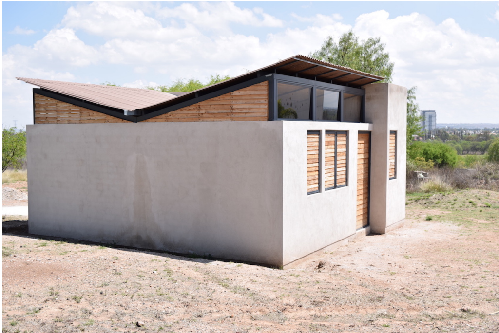
Figura 60. Vista de casa ecológica. Acabado de la casa: Aplanado con mortero de cal y tierra. Fotografía captura propia.
