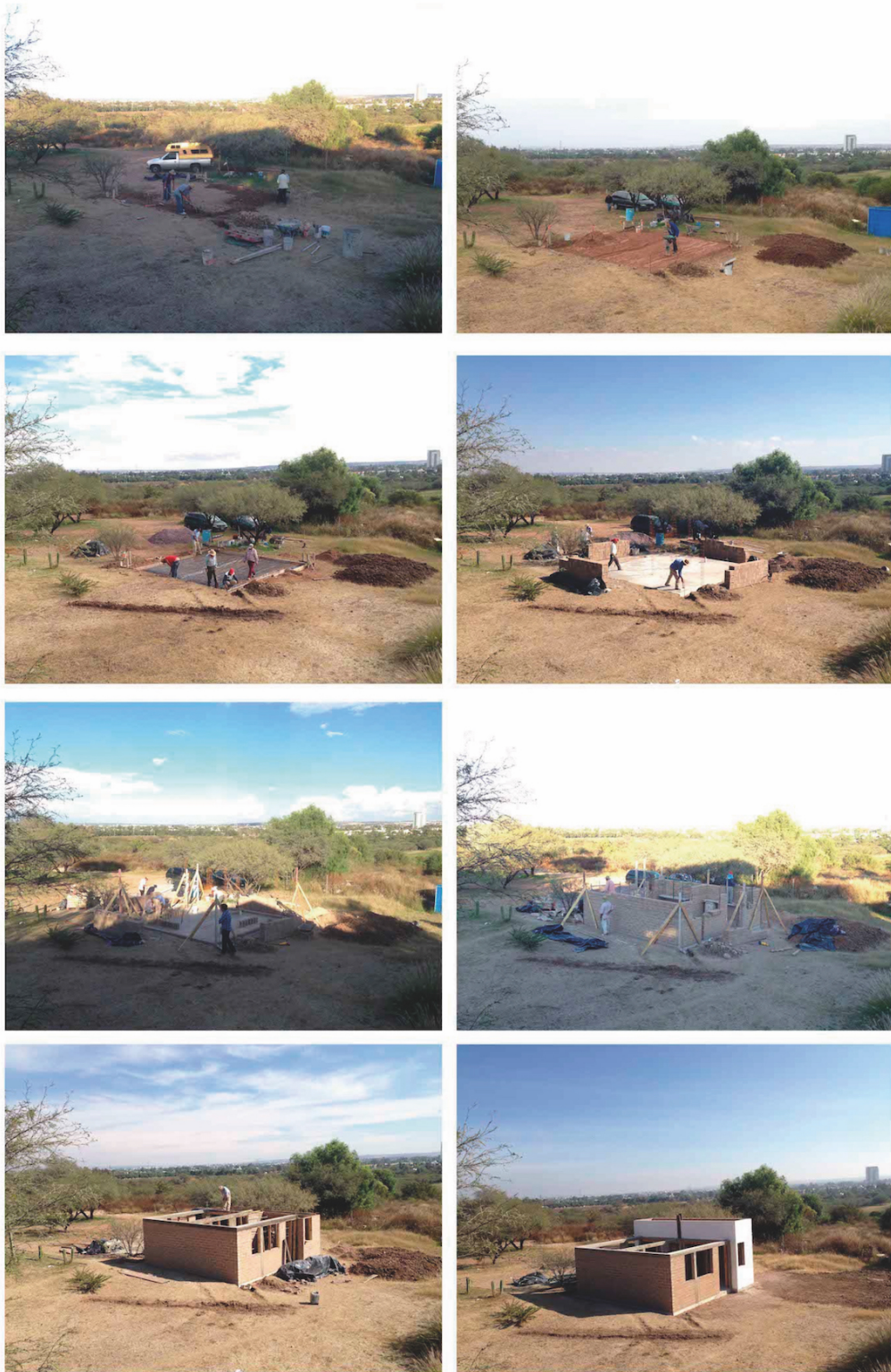
Figura 57. Proceso constructivo de la vivienda ecológica. Fotografía captura propia.
