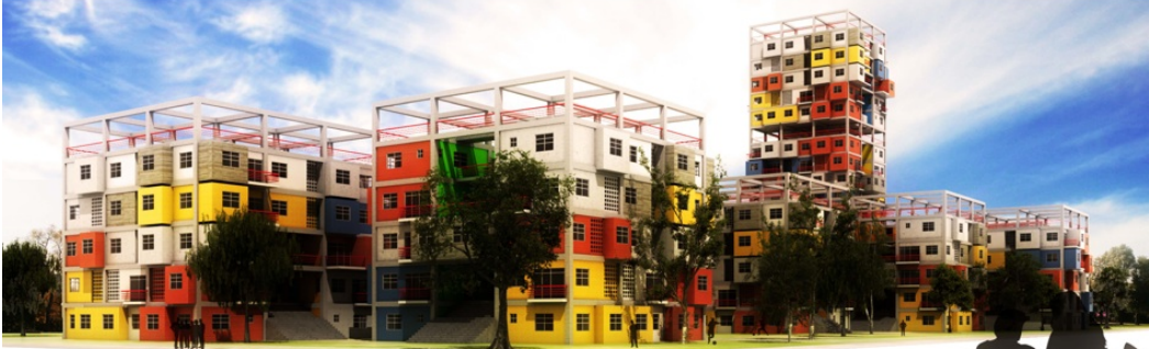
VISTA PANORÁMICA DEL CONJUNTO
