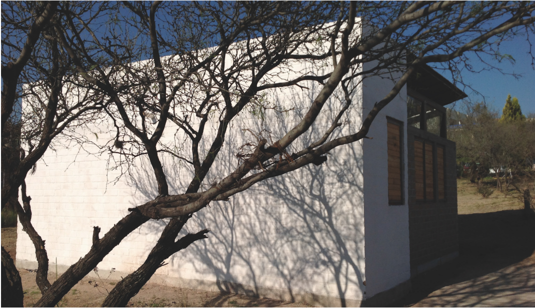
Figura 58. Vista de casa ecológica sin aplanado. Fotografía captura propia.
