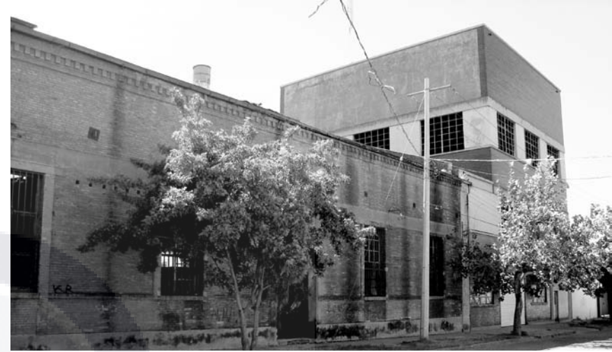
144 | EDIFICIO DE LA COMISIÓN FEDERAL DE ELECTRICIDAD
