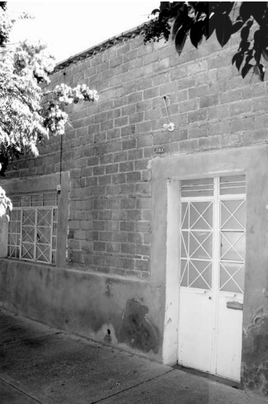
133 | VIVIENDA UNIFAMILIAR EN CALLE FÉLIX DE LA PAZ
