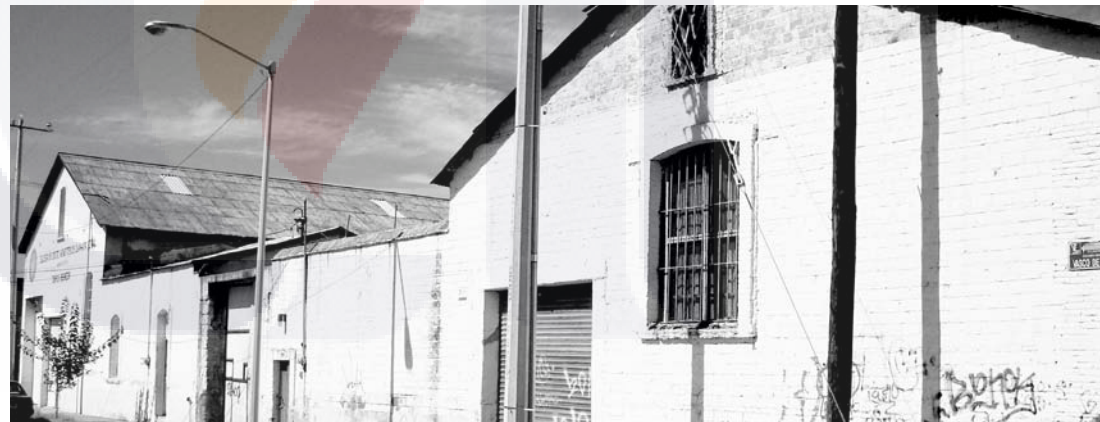
149 | NAVES INDUSTRIALES EN VASCO DE GAMA
