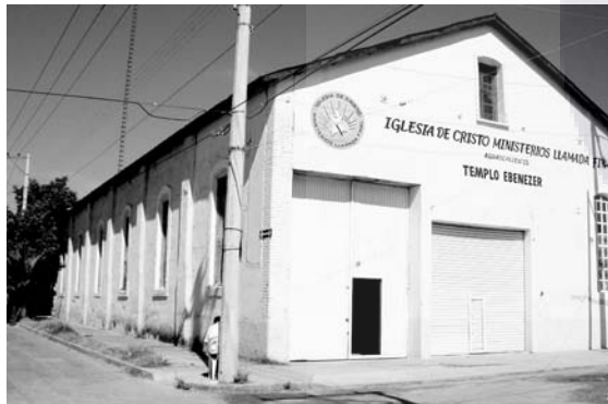
148 | NAVE INDUSTRIAL EN J. CONSUELO
