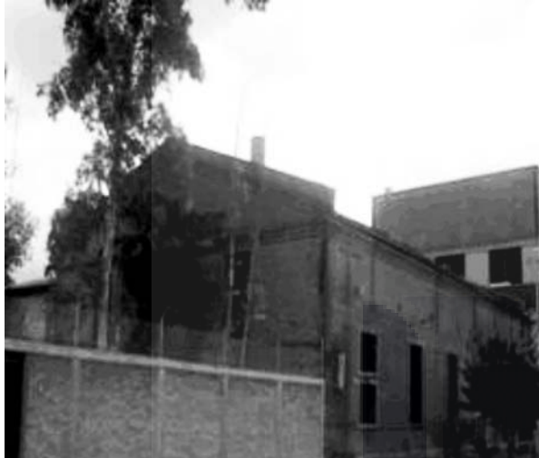
143 | NAVE DE LA ANTIGUA COMPAÑIA ELÉCTRICA DE AGS.
