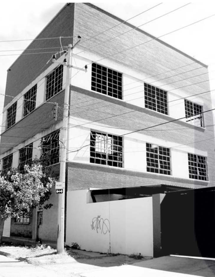
155 | EDIFICIO DE LA CASA DE FUERZA DE CFE
