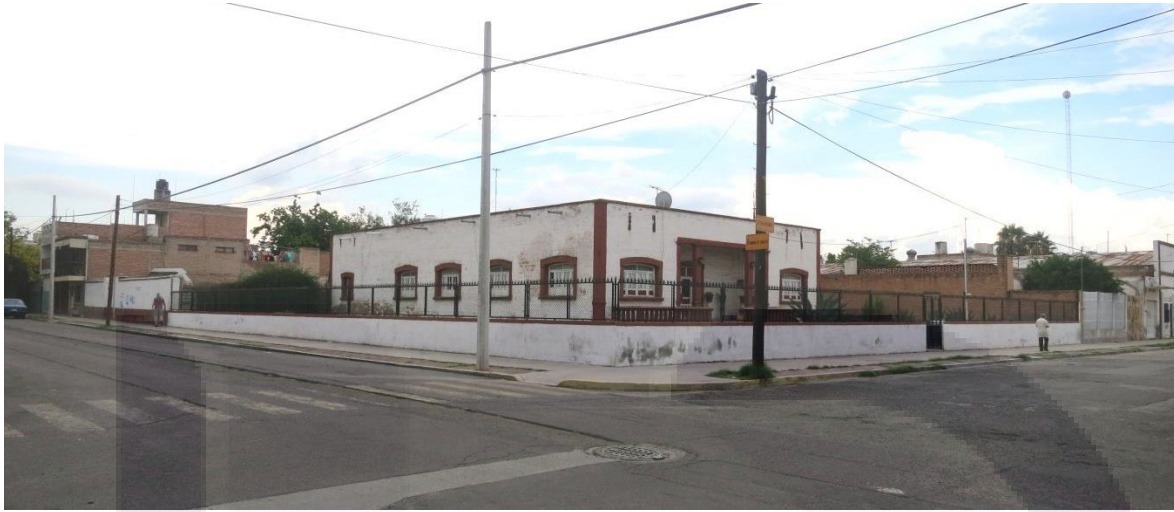
Gráfico 13. Vivienda con fachada deteriorada, esquina de calles Jerónimo de Orozco y 20 de noviembre
