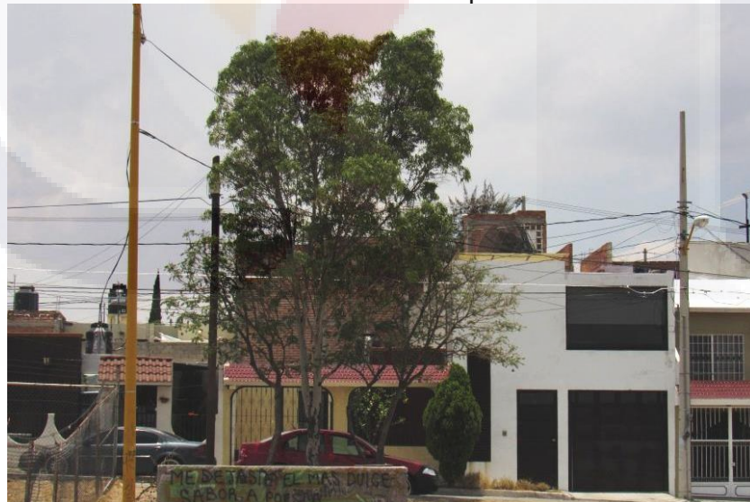
Gráfico 58. Diversidad en los diseños y acabados en las fachadas de las viviendas, Fraccionamiento Municipio Libre
