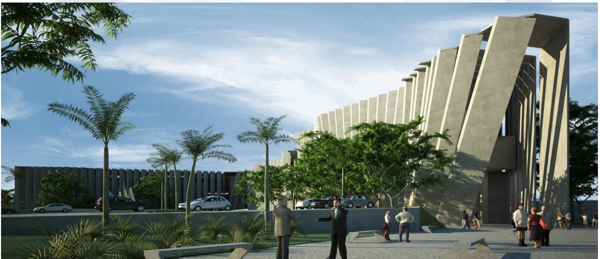
Imagen obtenida de la Secretaría de Obras Públicas del Estado
