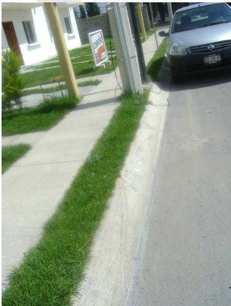
Aquí se observa la banqueta, el arriate, la guarnición tipo pecho paloma y el pavimento flexible (pavimento de concreto asfáltico).
