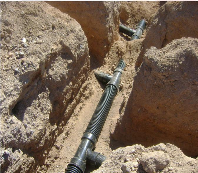
Aquí se observa la tubería para alcantarillado de polietileno alta densidad anular.
