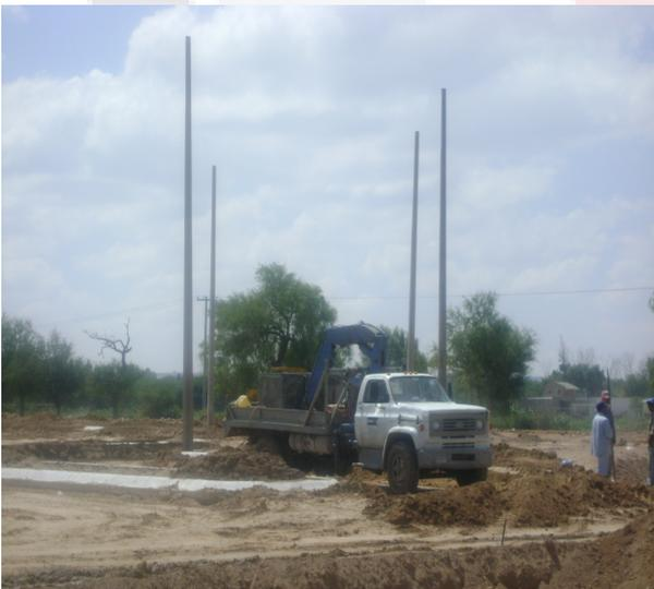
Aquí se observa la instalación eléctrica que es aérea la principal (media tensión) y la secundaria que es oculta (baja tensión), el sistema de electrificación es híbrido.
