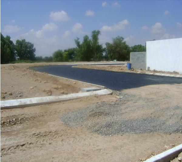
Aquí observamos la guarnición tipo pecho paloma y el pavimento flexible (pavimento de concreto asfáltico), este fraccionamiento esta actualmente en proceso de construcción..
