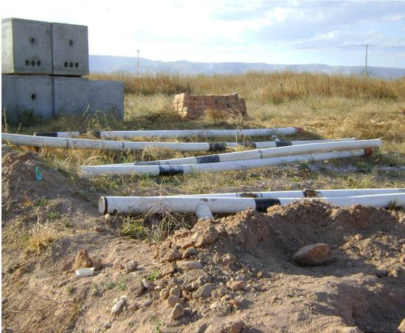
Aquí se observa los registros de electrificación para la línea de baja tensión.
