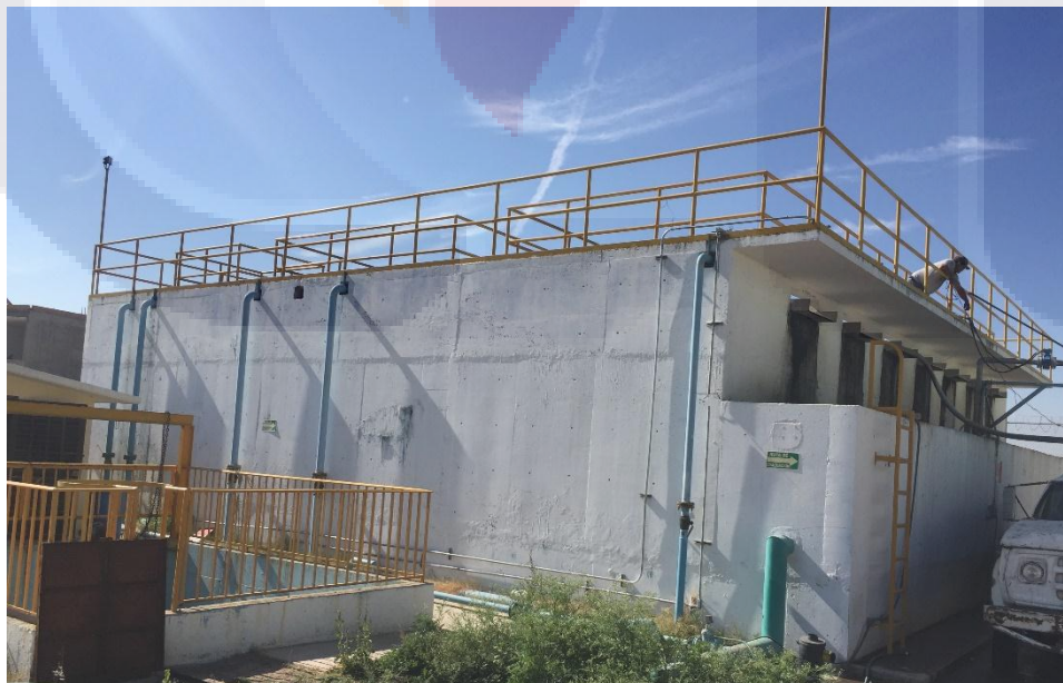
Ilustración 5 Planta de tratamiento La Querencia en Aguascalientes.
