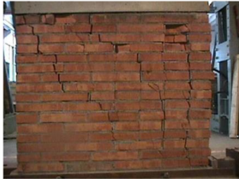
Figura 50 Rotura por compresión.
