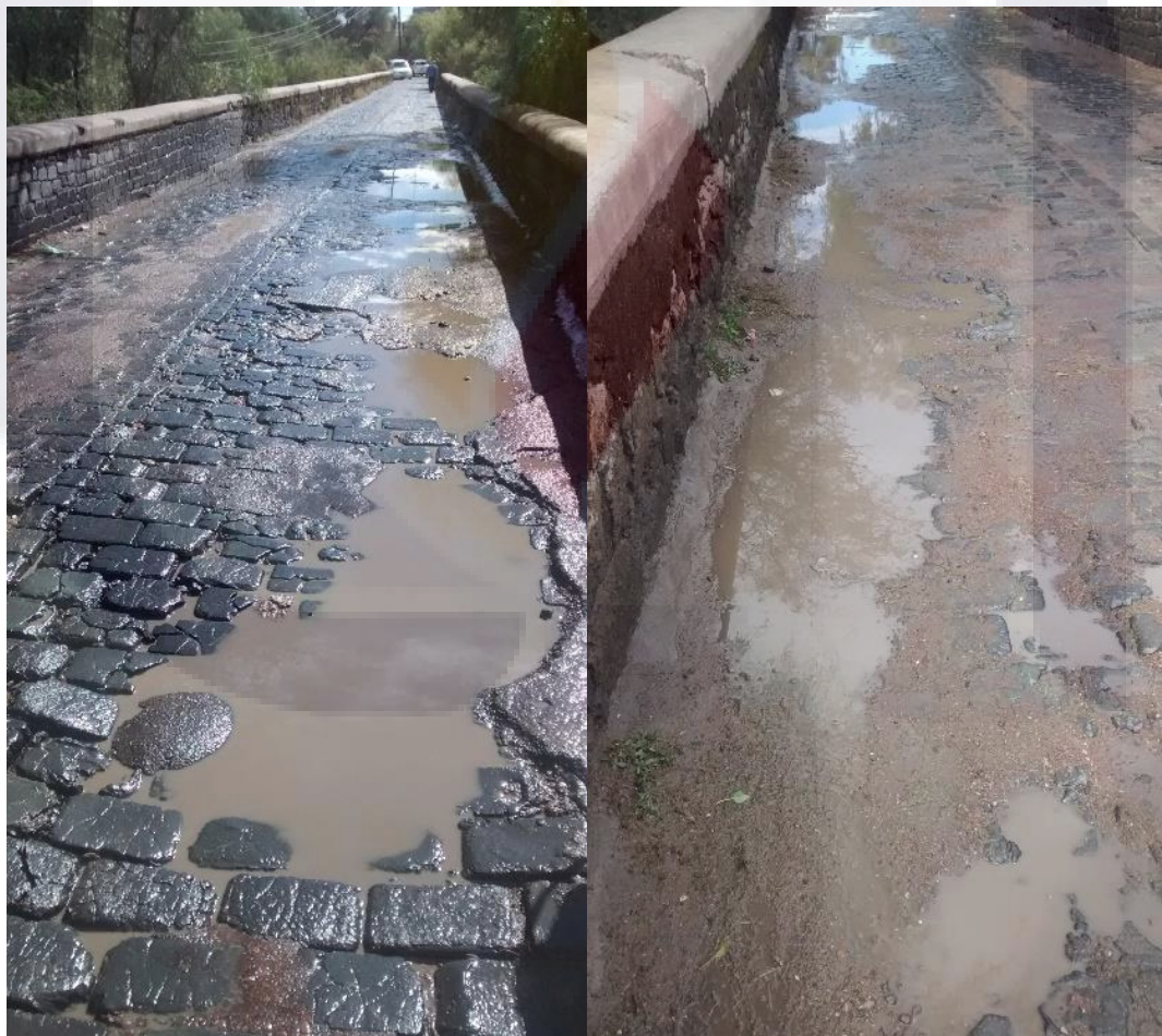
Imagen 16. Espejo de agua: figuras a y b, agua estancada en el puente, lado aguas abajo. Fuente propia.
