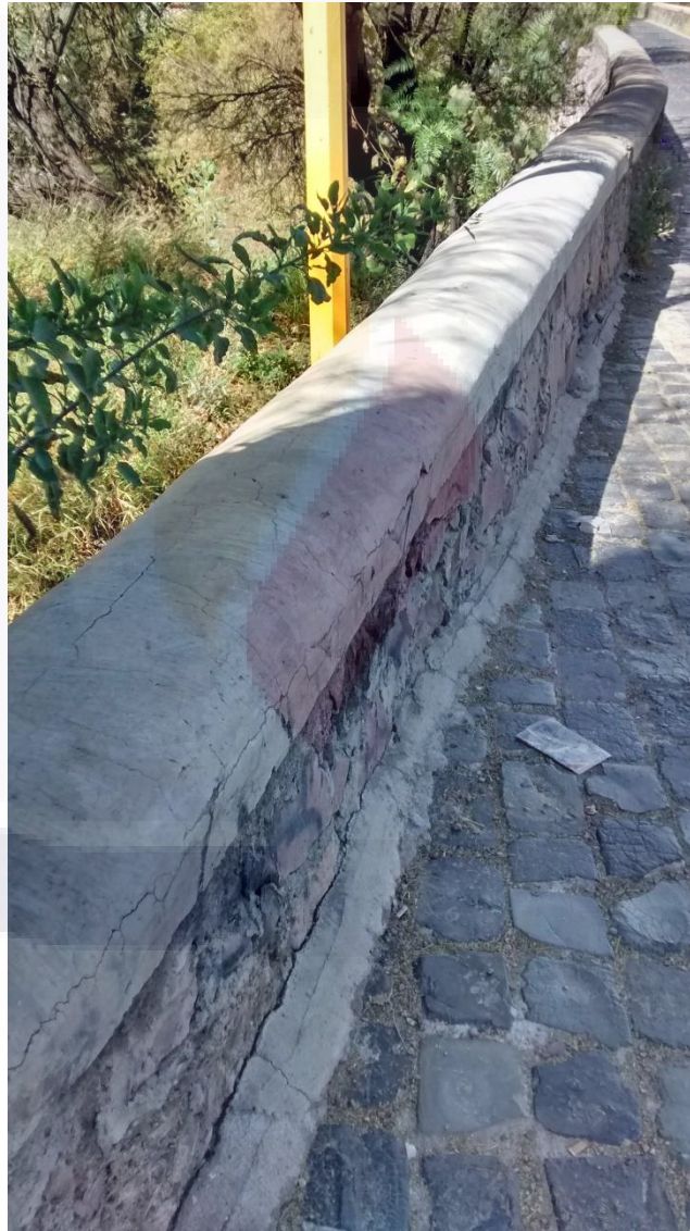
Imagen 23. Manguera de plástico atravesando el puente, cubierta con mezcla de mortero. Fuente propia.
