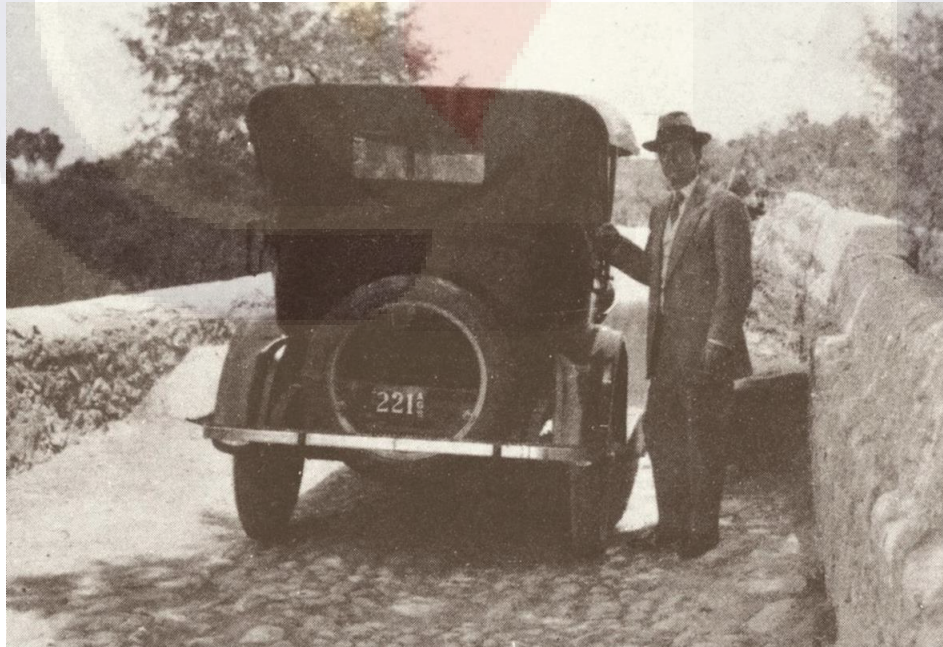
Imagen 48. Fotografía antigua del puente de San Ignacio con empedrado a base de piedra bola. Fuente: desconocida.
