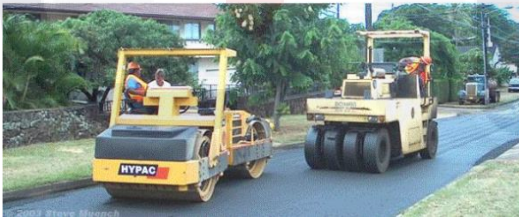
Imagen 62. Fotografía representativa de pavimento de asfalto, etapa de compactación, (Bonett, 2014).
