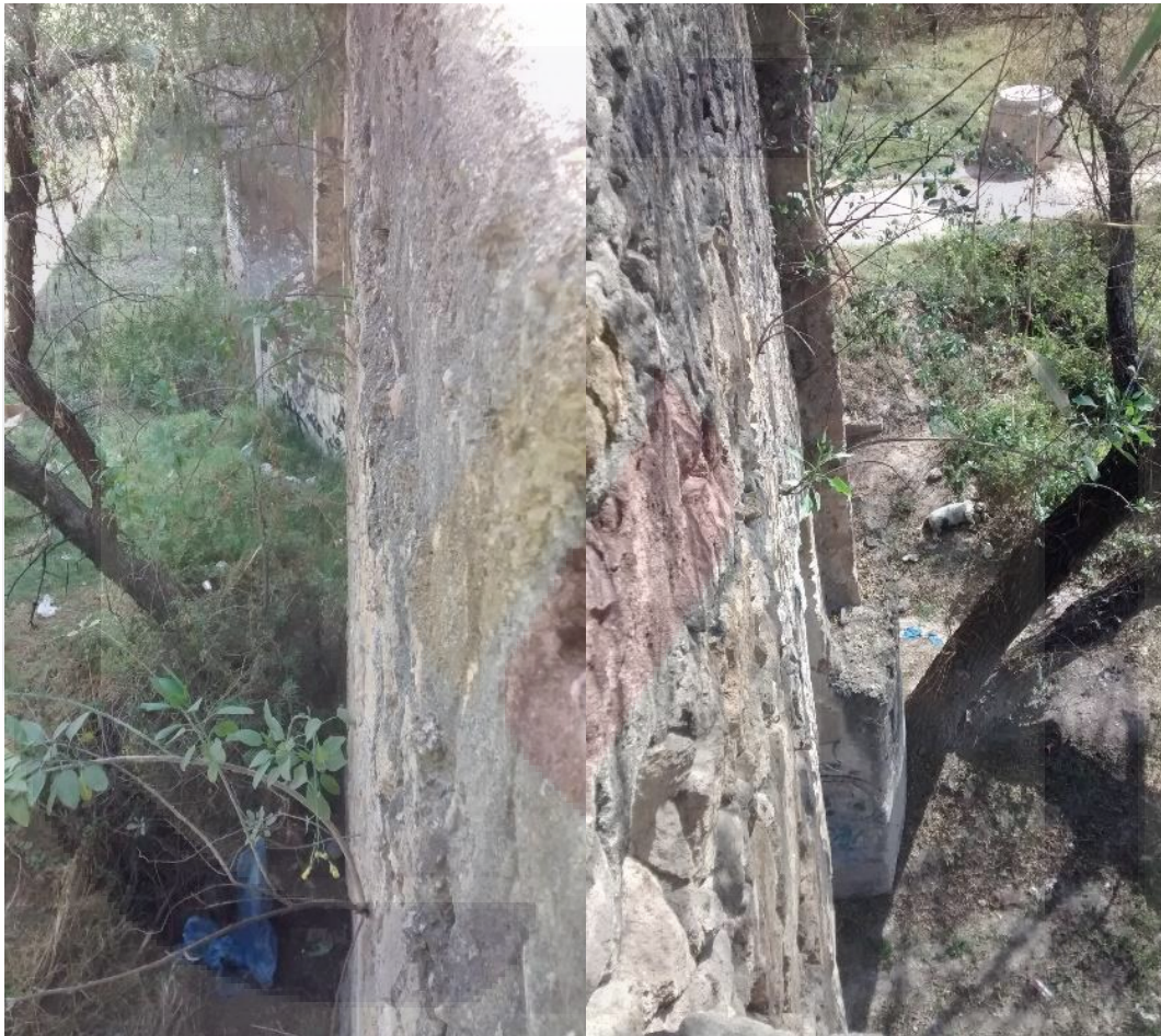
Imagen 30. Árboles crecientes junto al puente: figura a, árbol aguas arriba y figura b, árbol aguas abajo. Fuente propia.
