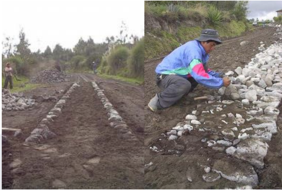
Imagen 66. Pavimento de piedra bola: figura a. muestras de piedra para calzada; figura b, confinamiento de piedra. Fuente: Argüello & Ramón, (2004 pp. 22,23).
