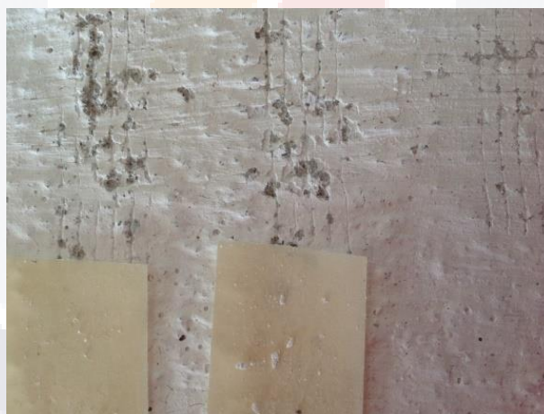
Figura 4.94 Clasificación 2B (20% de remoción) en el panel de mortero en acabado fino con el recubrimiento de PFR.
