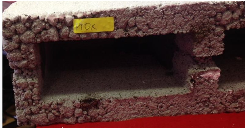
Figura 4.5 Material de construcción con espacios huecos en su conformación, Block.
