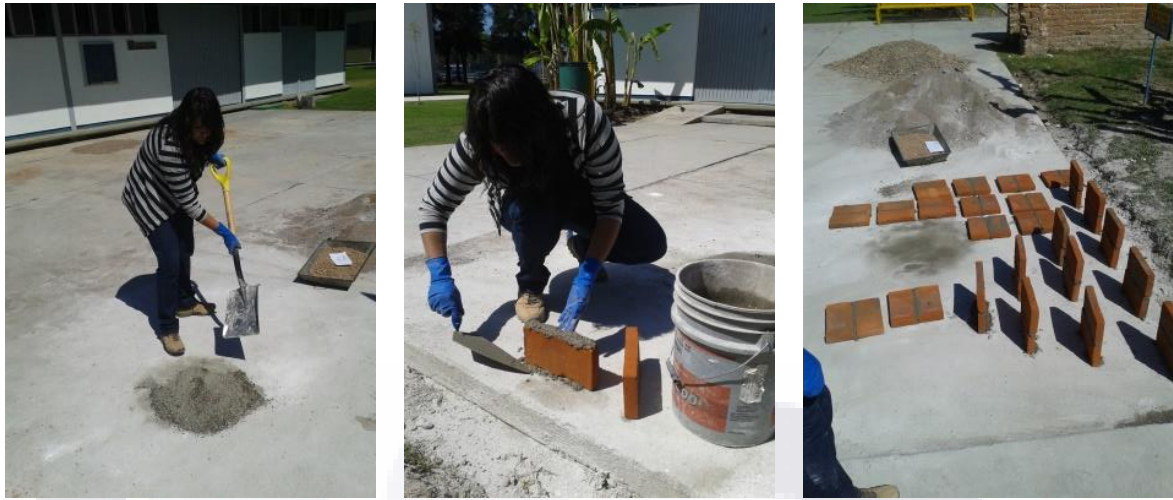
Figura 3. 4 Fabricación de los paneles a base de tabique usado comúnmente en la región.
