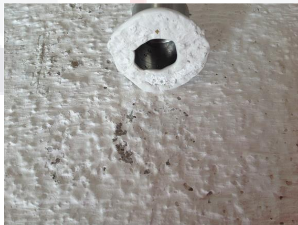
Figura 4.50 Panel de mortero en acabado rugoso en la prueba de permeabilidad, superficie irregular.
