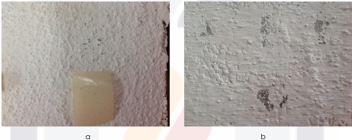
Figura 4.88 Área de corte de la prueba de adherencia sobre los paneles de mortero con acabado rugoso con recubrimientos de PFC1 (a) y PFN1 (b).
