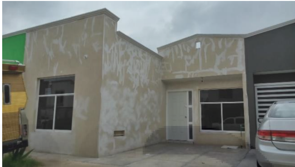
Imagen 2 Reparación de fisuras en aplanado de mortero en vivienda del fraccionamiento Misión de Santa Lucía, Aguascalientes, Ags.
