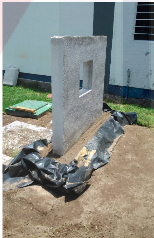
Imagen 48 Colocación de tierra vegetal combinada con composta en contenedor habilitado en la base de los muretes.
