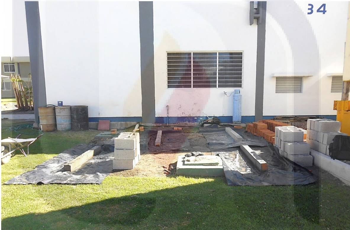
Imagen 23 Dalas de desplante fraguadas sobre hojas de polietileno negro
