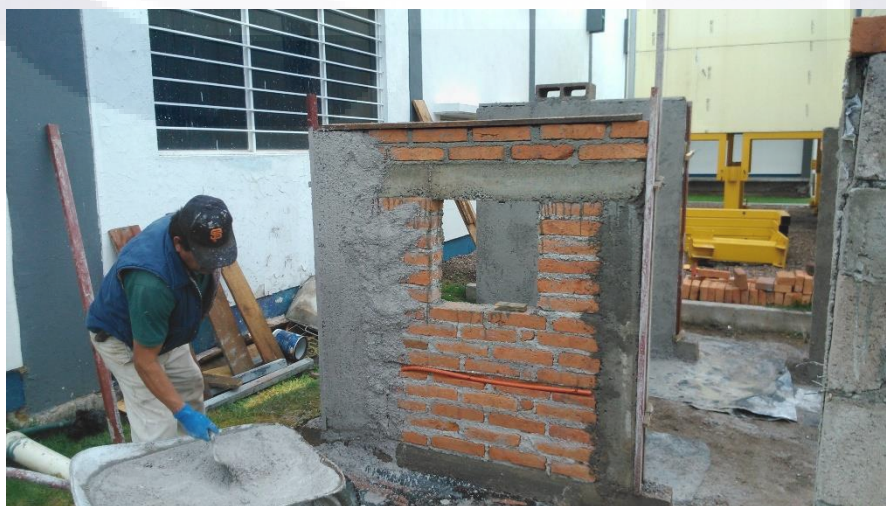
Imagen 31 Aplicación de repellado de MCAL sobre MTR 1-A.
