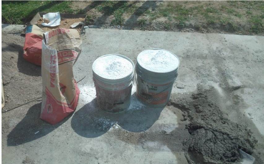
Imagen 27 Medición de las partes de cal en botes de plástico de 19 litros.
