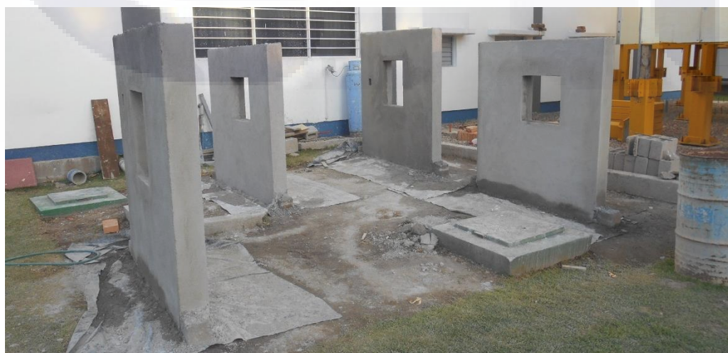
Imagen 42 Panorámica de muretes recién aplanados con segunda capa de mortero.
