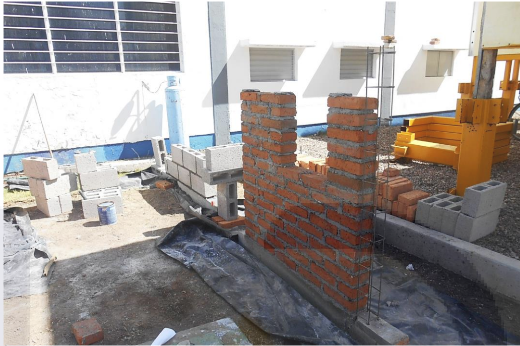
Imagen 24 Avance de construcción de muretes: mampostería asentada hasta nivel de cadena de cerramiento y anclaje de castillo de MTR 2
