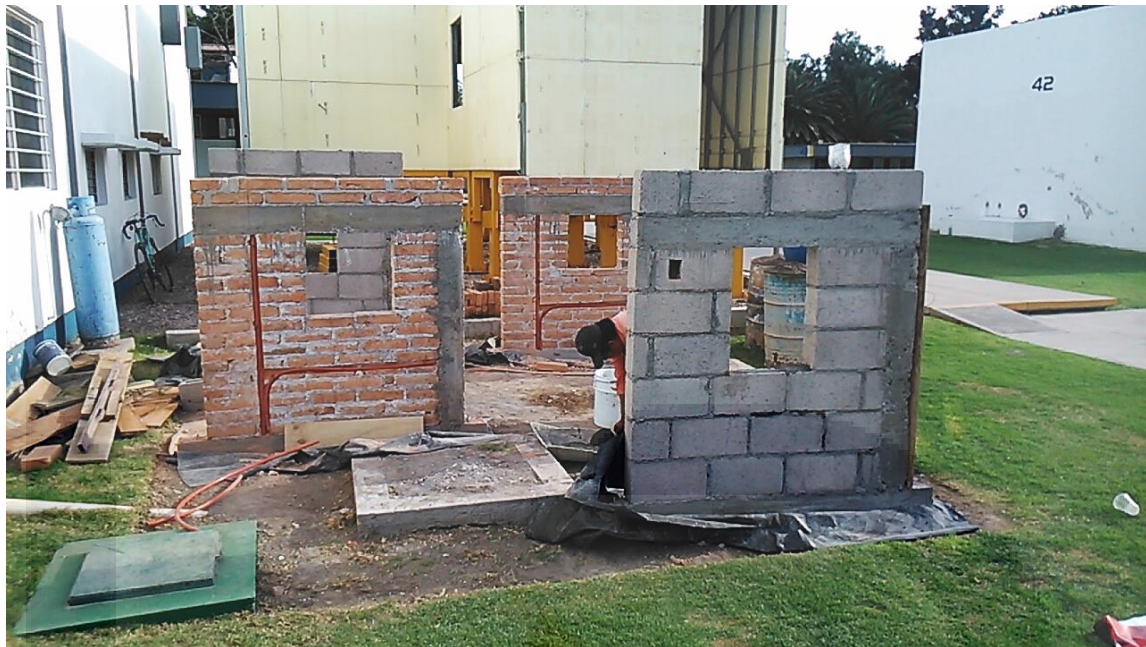
Imagen 26 Panorámica de muretes recién construidos
