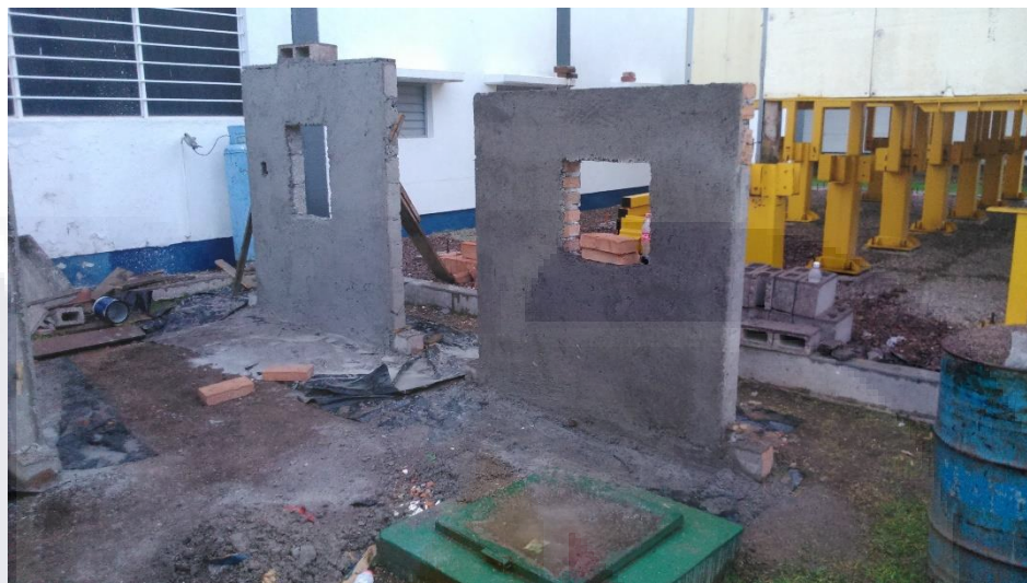
Imagen 32 Repellado concluido de MCCA sobre MBC2-A (izquierda) y de MCPA sobre MTR 2-A (derecha).
