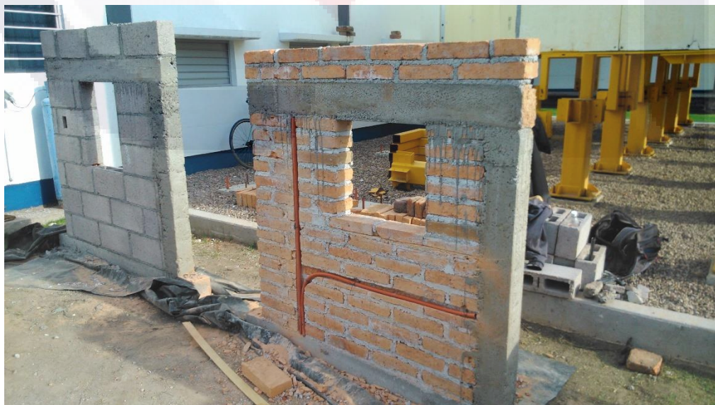
Imagen 25 Construcción de MTR 2 y MBC 2 concluida, incluyendo ranurado e instalación de poliducto de 1/2" en MTR y perforación de hueco para caja registro en MBC
