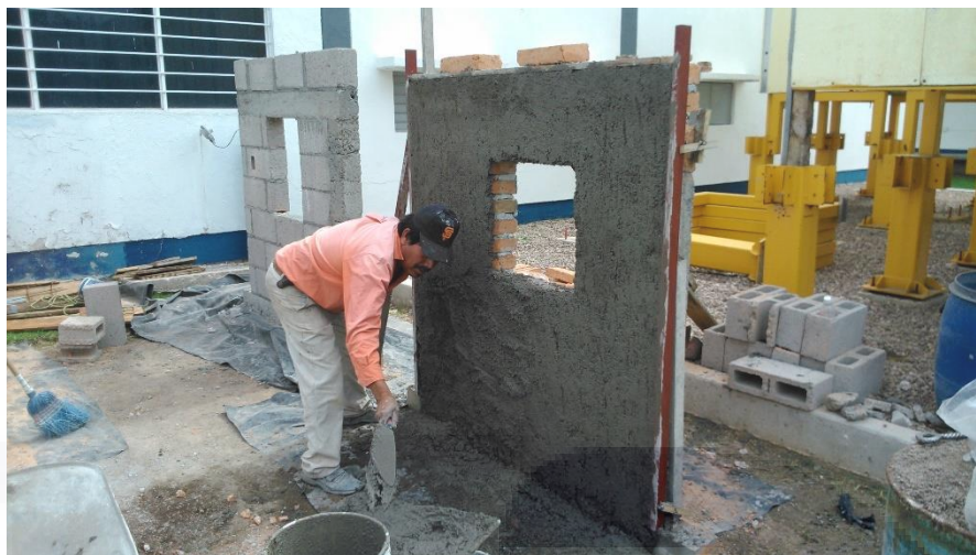
Imagen 29 Aplicación de repellado de MCPA sobre MTR 2-A.
