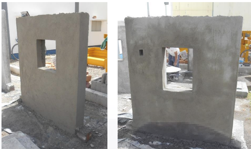
Imagen 40 Segunda capa de mortero recién aplicada. (Izq.) MTR 2-A-MCPA, (Der.) MBC 1-A-MCEM.
