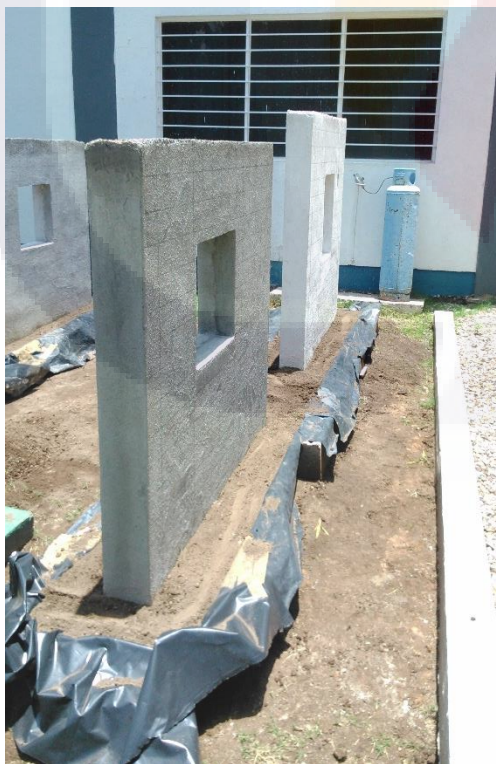
Imagen 48 Colocación de tierra vegetal combinada con composta en contenedor habilitado en la base de los muretes.
