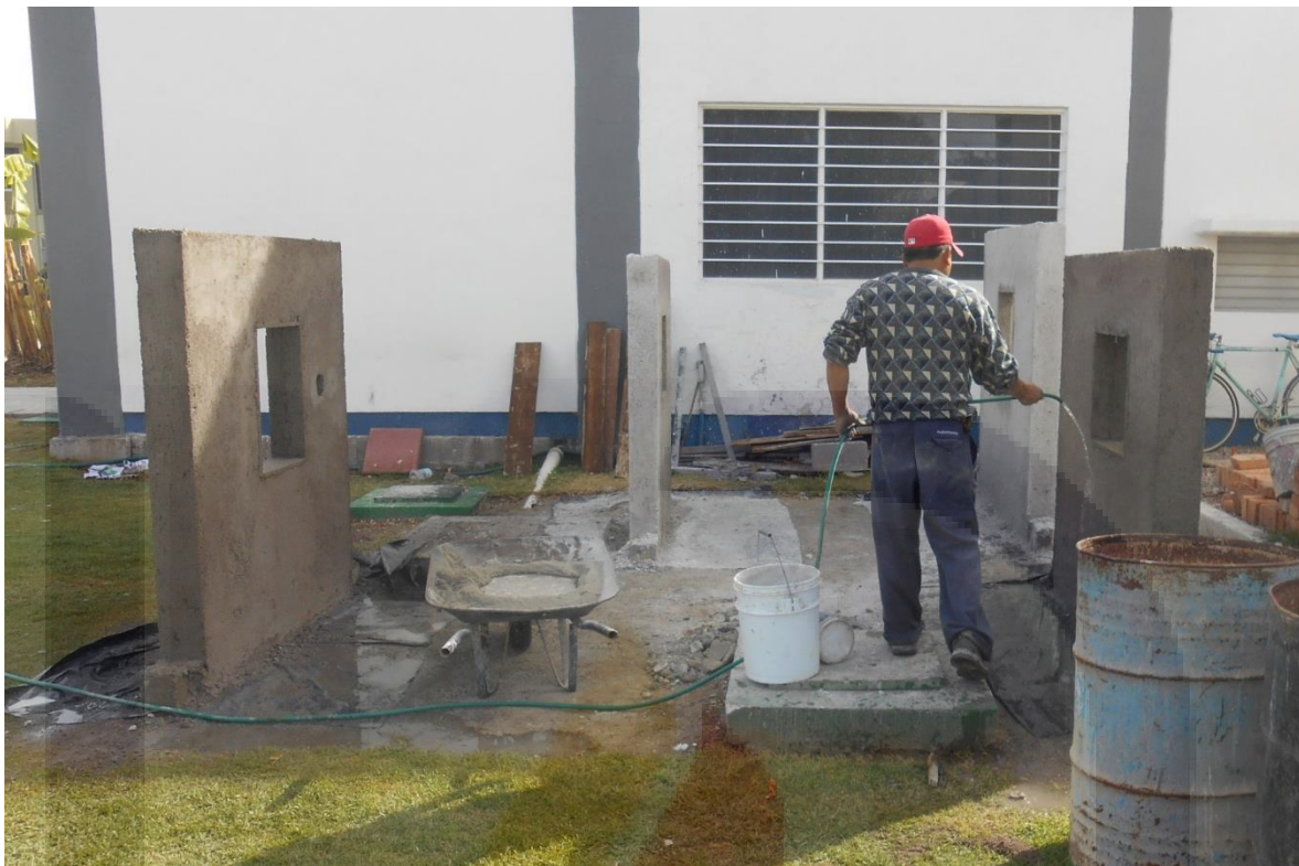
Imagen 38 Mezcla dispuesta para el amasado en carretilla y humedecimiento de la primera capa de aplanados.
