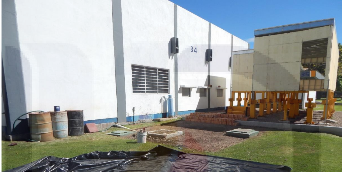
Imagen 13 Terreno preparado para la construcción de muretes de prueba.
