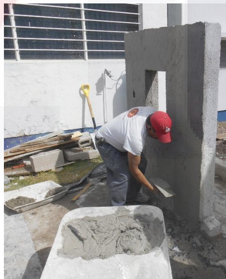
Imagen 39 (Izq.) Aplicación de mortero fino de MCEM sobre MBC 1-A. (Der.) Aplicación de mortero fino de MCCA sobre MBC 2-A.
