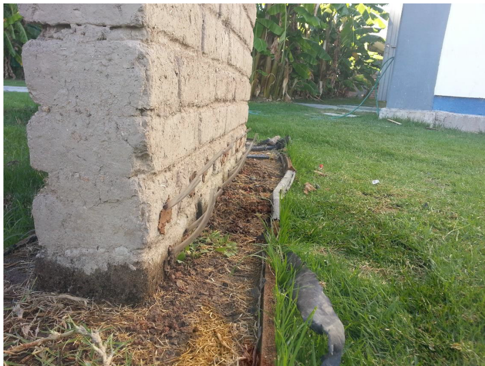
Ilustración 64 vista lateral de muro.
