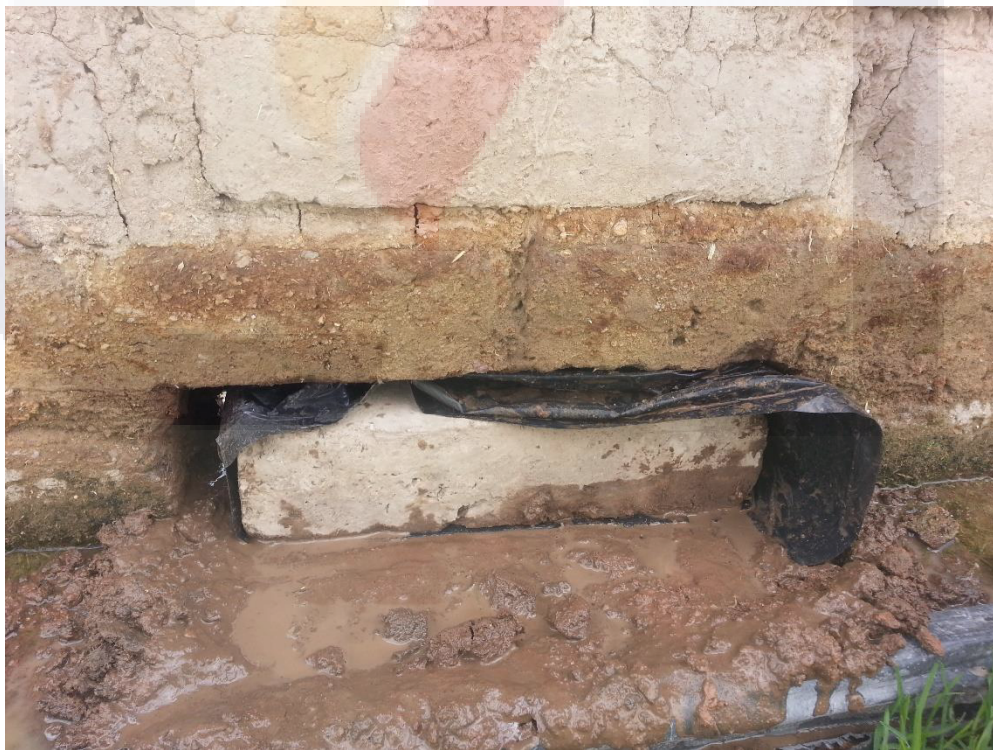
Ilustración 49 colocación de adobe con protección
