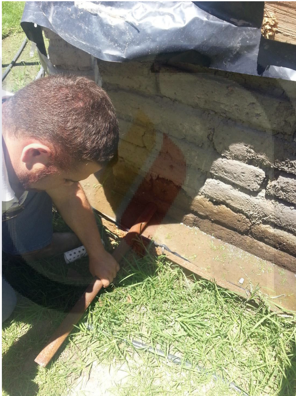
Ilustración 39 preparación para recibir aerotubo
