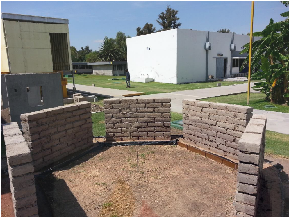
Ilustración 35 conjunto de muretes construidos
