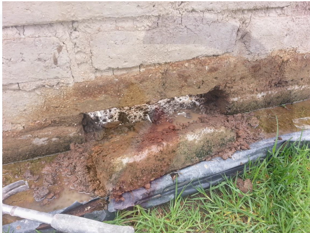
Ilustración 47 quitando elemento saturado
