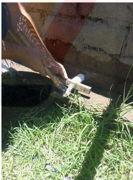
Ilustración 41 colocación de aerotubo
