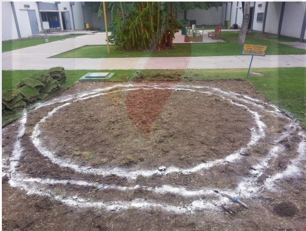
Ilustración 22 Trazo para distribución de muros
