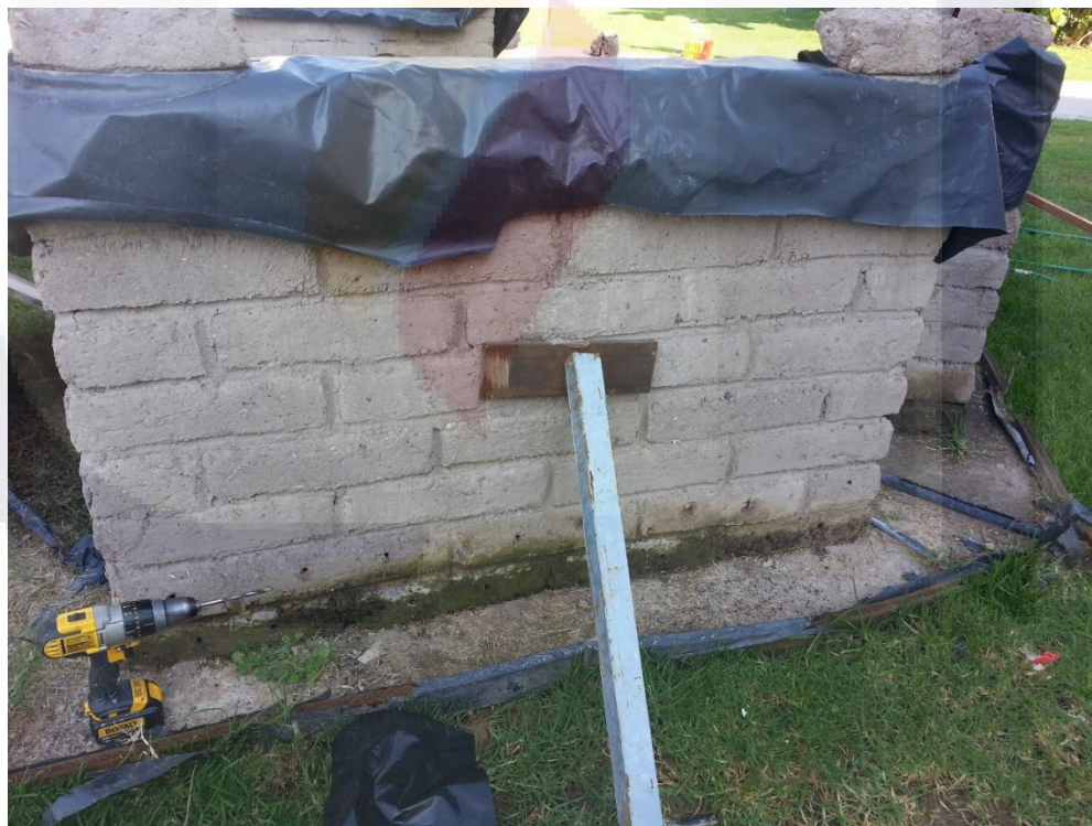
Ilustración 59 murete listo para implementar sistema de inhibición.
