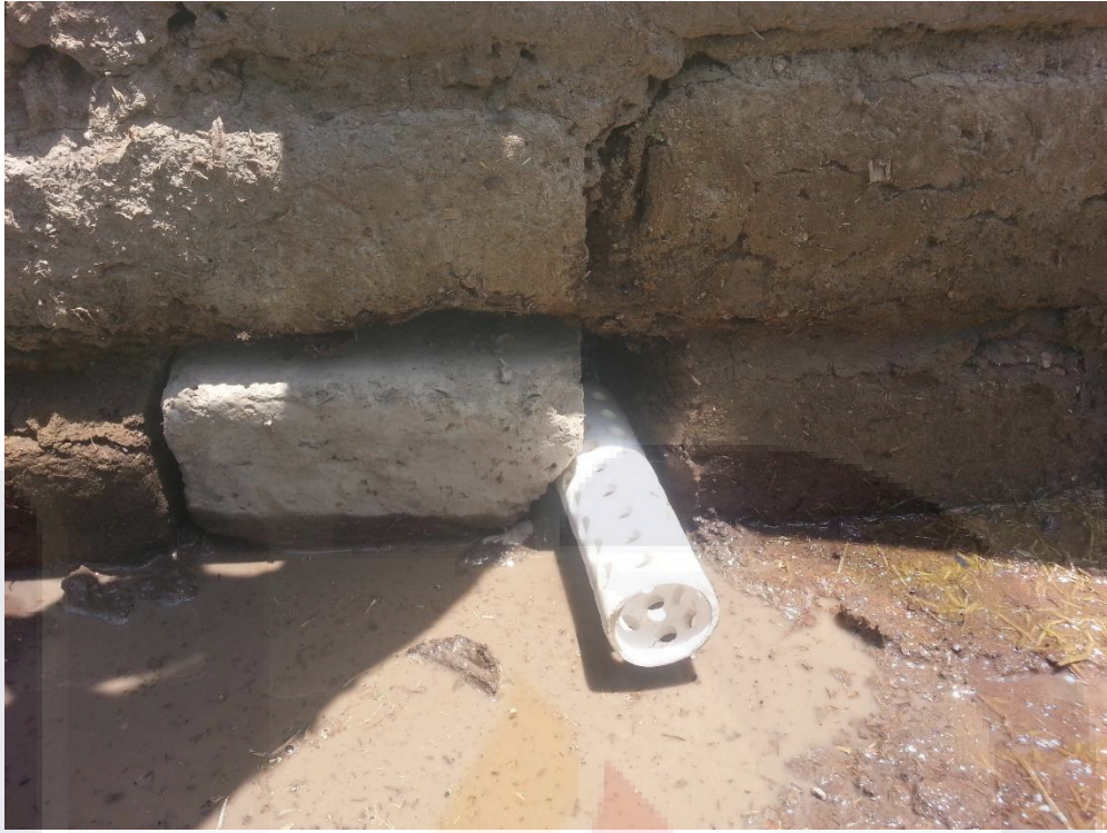
Ilustración 45 Elemento nuevo con aerotubo
