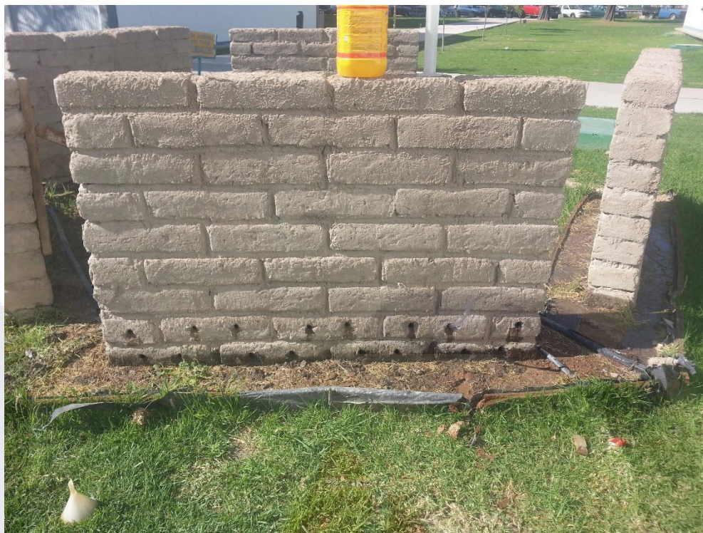
Ilustración 62 muro con producto químico aplica en toda el área barrenada.
