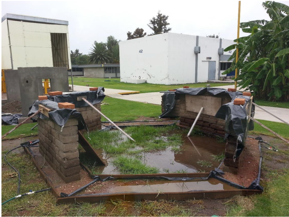
Ilustración 38 aseguramiento de muros
