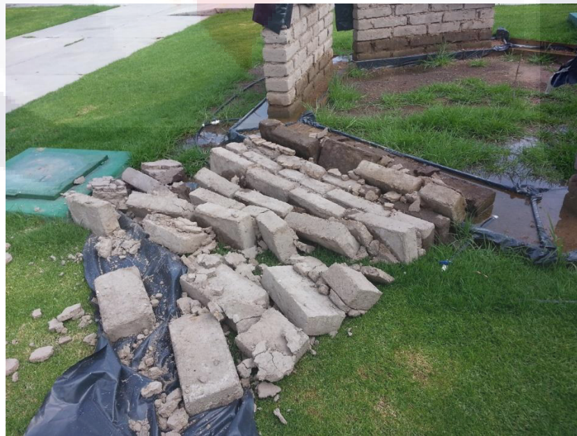
Ilustración 37 mocheta colapsada
