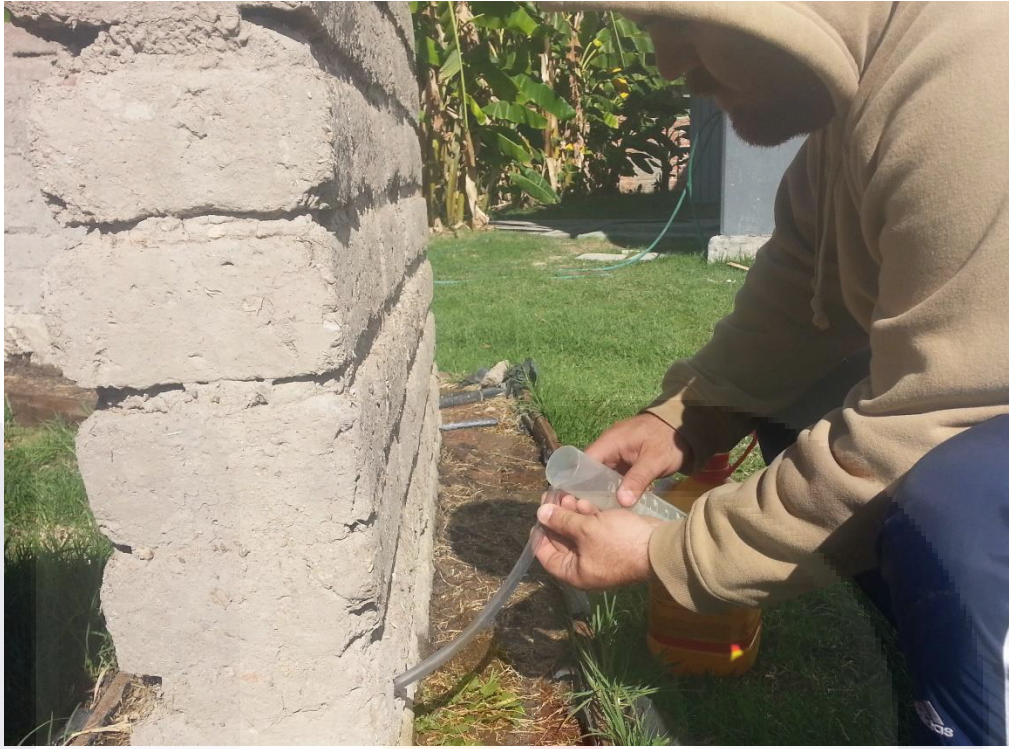
Ilustración 60 colocación de mangueras de nivel.
