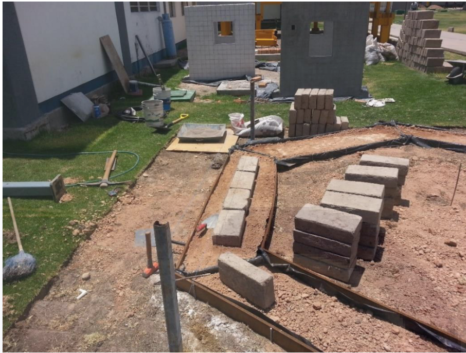
Ilustración 31 inicio y preparación de murete
