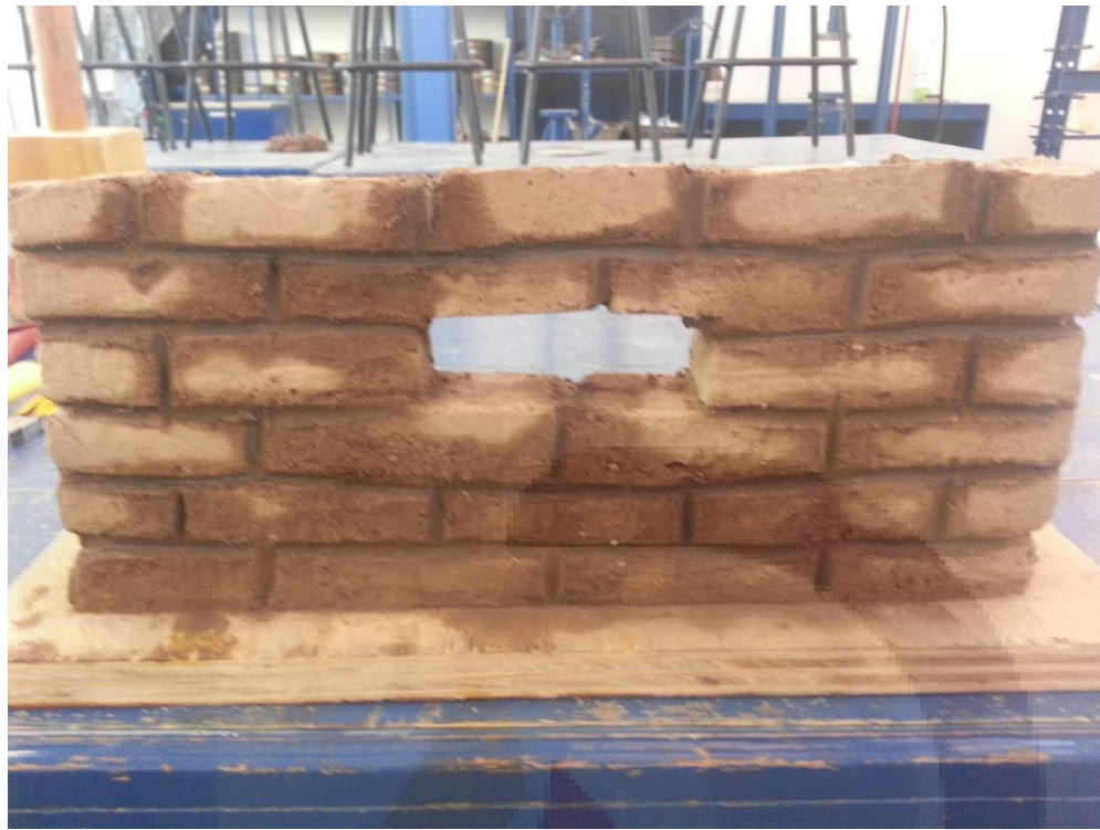
Ilustración 11 Murete con juntas trabajadas
