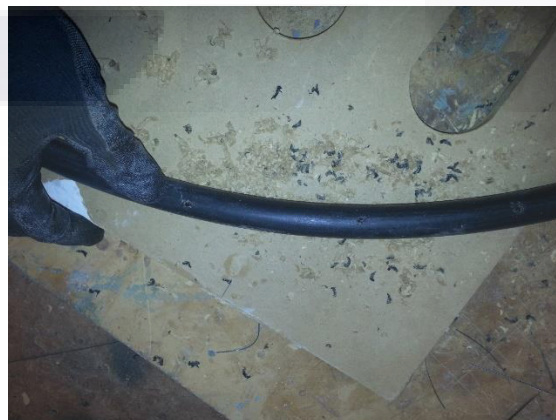
Ilustración 25 manguera perforada para sistema de riego
