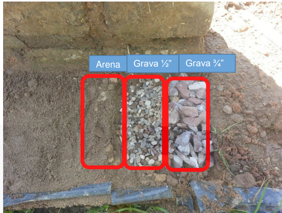
Ilustración 57 corte demostrativo por capas
