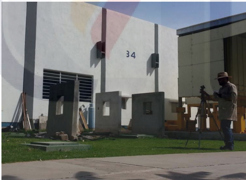
Ilustración 21 Zona vecina donde se realiza la plataforma de cimentación
