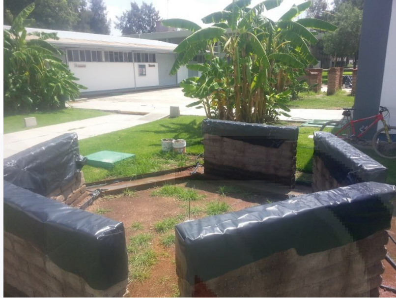
Ilustración 36 protección para erosión por lluvia
