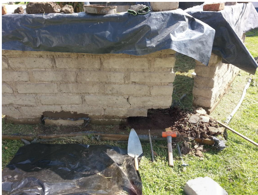
Ilustración 50 se junta el elemento nuevo y se prepara el siguiente
