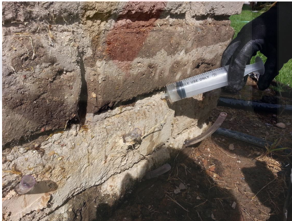
Ilustración 65 aplicación de químico con jeringa.
