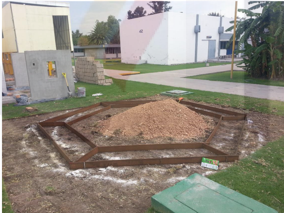
Ilustración 23 Cimbra frontera para plataforma
