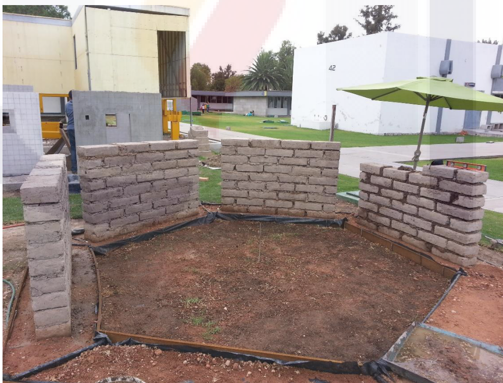
Ilustración 34 conjunto de muretes en construcción
