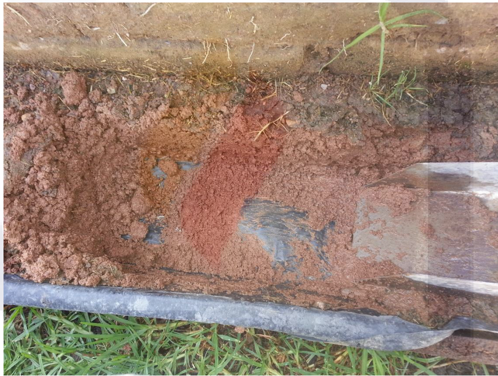
Ilustración 52 se quita el suelo saturado
