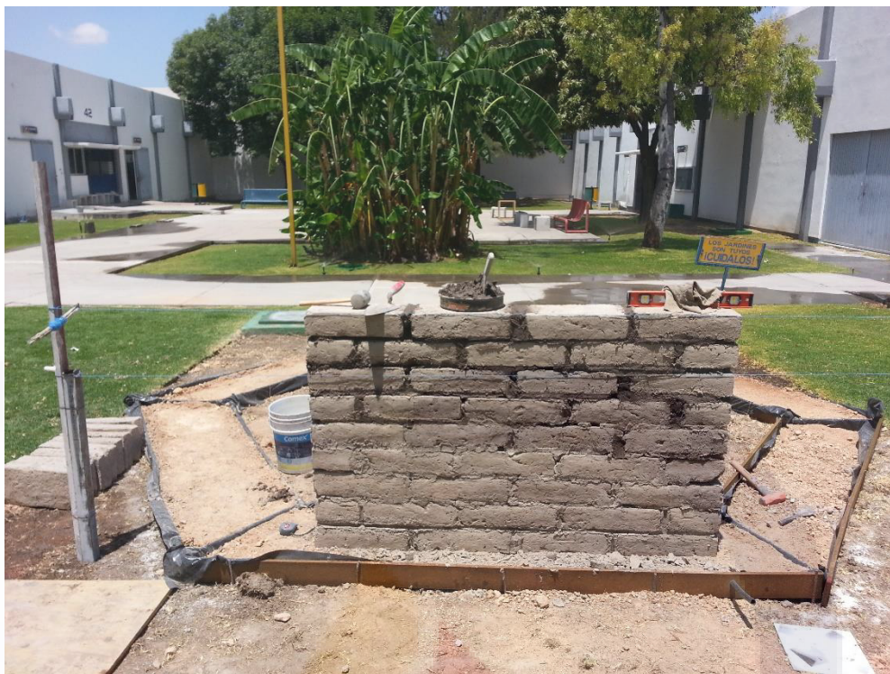
Ilustración 33 construcción de primer murete
