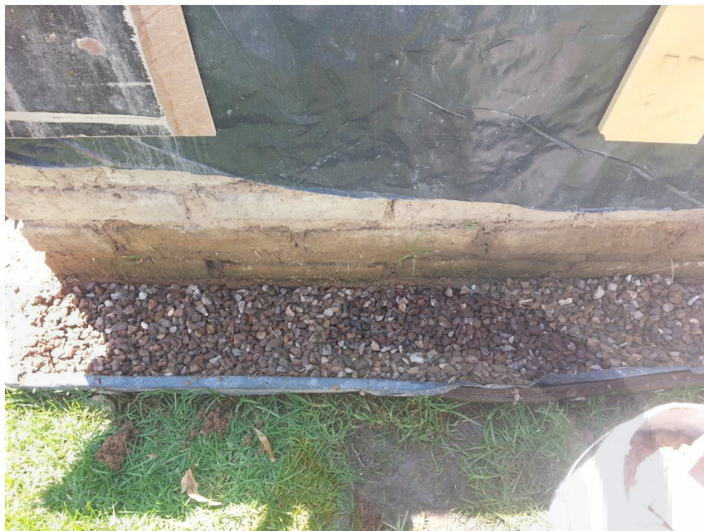
Ilustración 55 primera capa de grava
