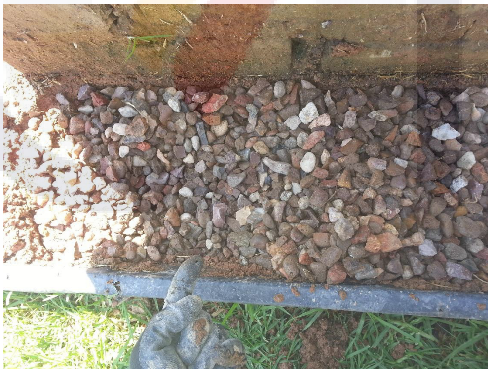
Ilustración 56 segunda capa de grava
