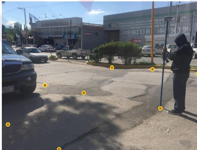
Figura 42.- Levantamiento de las fallas con Equipo GPS en RTK
