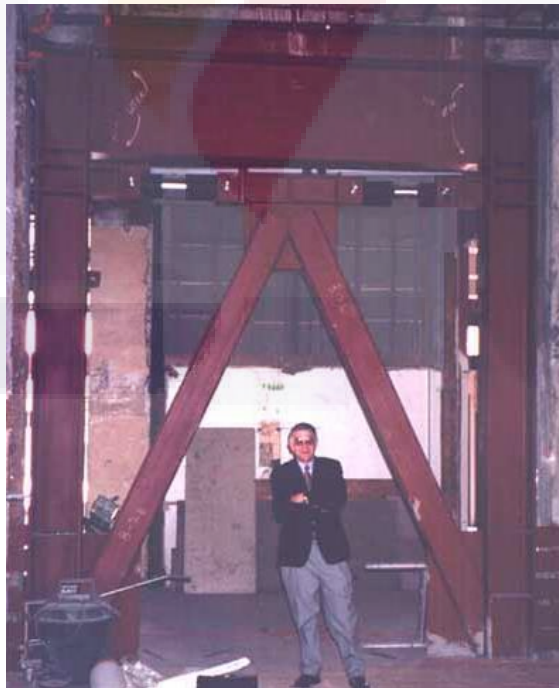
Figura 2.4 Mecanismo de disipación energética en edificio de mampostería (Winters Craig n.d.)
