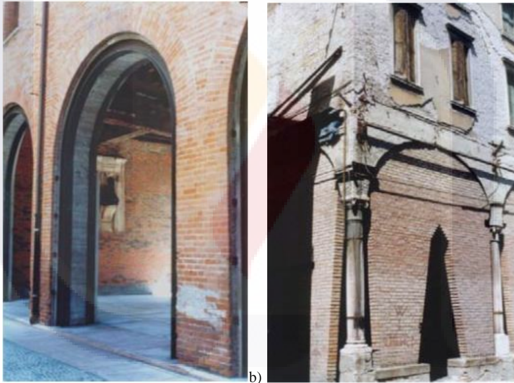
Figura 3.1 Ejemplos del principio de alteración: a) solución que altera poco el sistema original; b) solución que altera totalmente el sistema original (Peña F. and Lourenço P. 2012)
