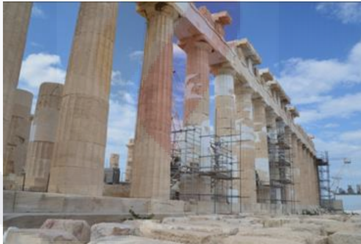
Figura 2.1 Reparación y refuerzo del Partenon de Atenas
