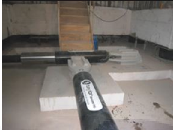
Figura 2.3 Uso de mecanismos de disipación energética en un edificio histórico de Bucarest, Rumania (Winters Craig n.d.)
