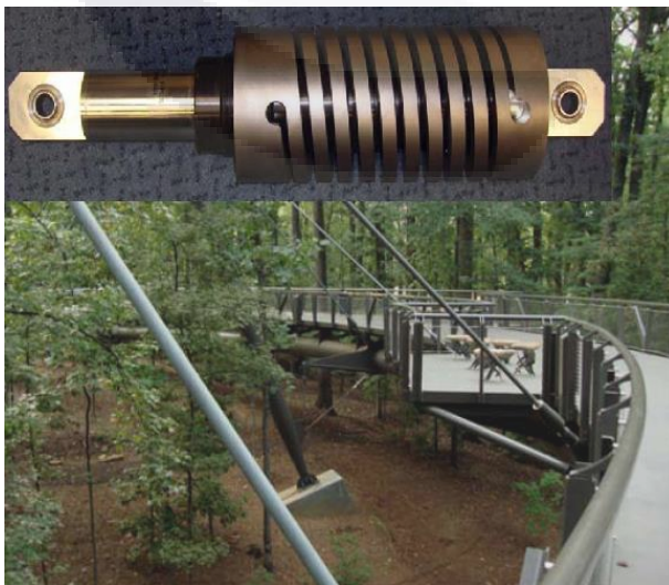
Figura 3.7a Muestra un puente peatonal en un parque de Atlanta, E.U. esta plataforma cuenta con un mecanismo de disipación energética formado por un amortiguador visco-elástico sólido a base un resorte para disipar las vibraciones ocasionadas por el movimiento de los peatones o el viento. (Winters Craig n.d.)
