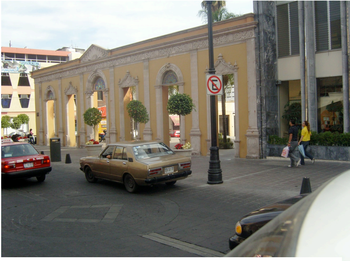
Figura 55.-JF.1-Foto de la Restauración de la Fachada principal de lo que fue el Hotel Washington, sobre la antigua calle Washington, actual Dr. Jesús Díaz de León. Fuente: Fotografía Fondo EGDVR, 2008.
