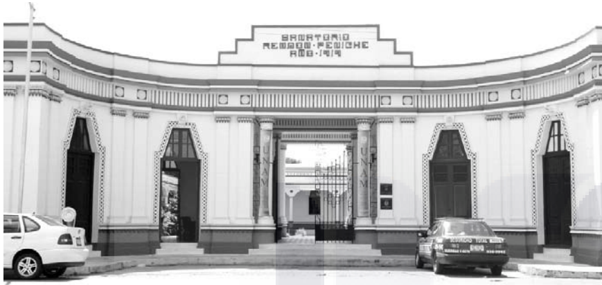
Fig. 6 Fachada principal del Sanatorio Rendón Peniche.
