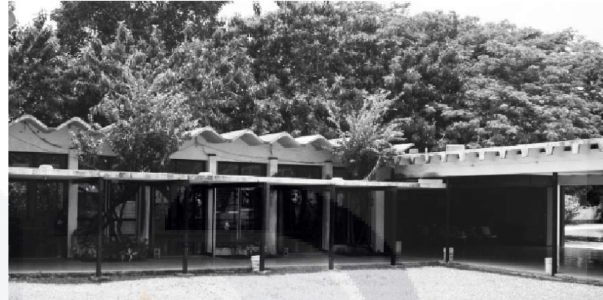
Fig. 53 Losas de concreto armado apoyadas en traveses y columnas metálicas, patio de la Casa de la Cristiandad.
