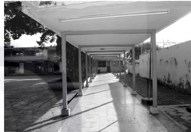
Fig. 77 Colegio Ignacio Zaragoza, pasillo de comunicación.
