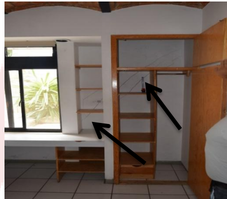
Muro planta baja F entre ejes 13 y 14
