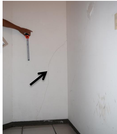
Muro planta baja eje 14 entre ejes C y D
