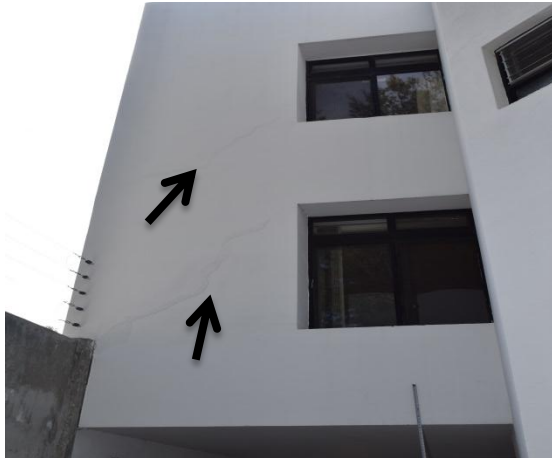
Muros 1 er y 2 do nivel eje 18
