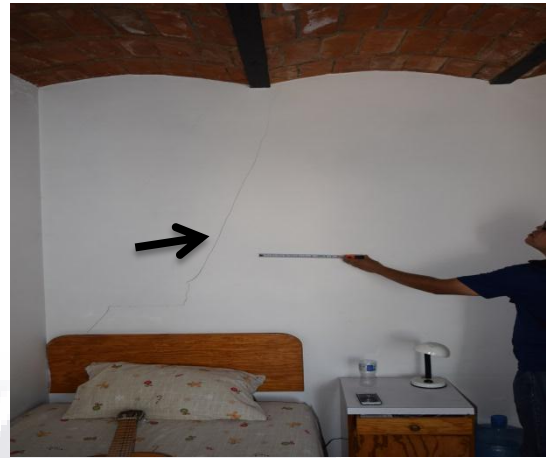
Muro 1 er nivel eje 17
