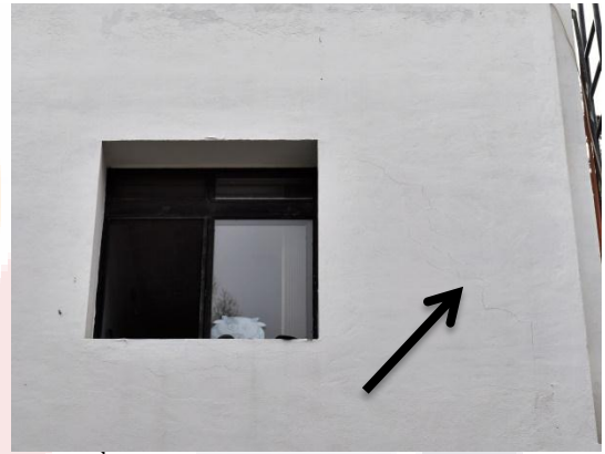
Muro 2 do nivel eje A entre ejes 1 y 2
