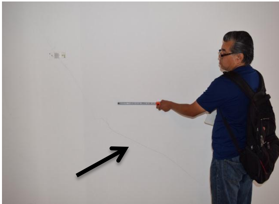
Muro 1 er nivel eje C entre ejes 9 y 12
