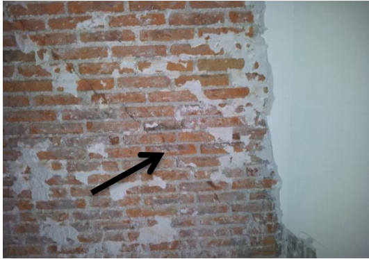
Muro planta baja eje C entre ejes 12 y 14
