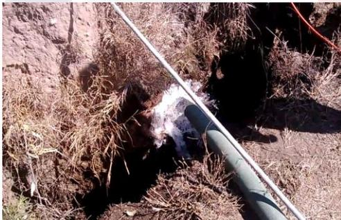
**Figura 46. Vaciado de agua potable en el punto de pruebas.**
