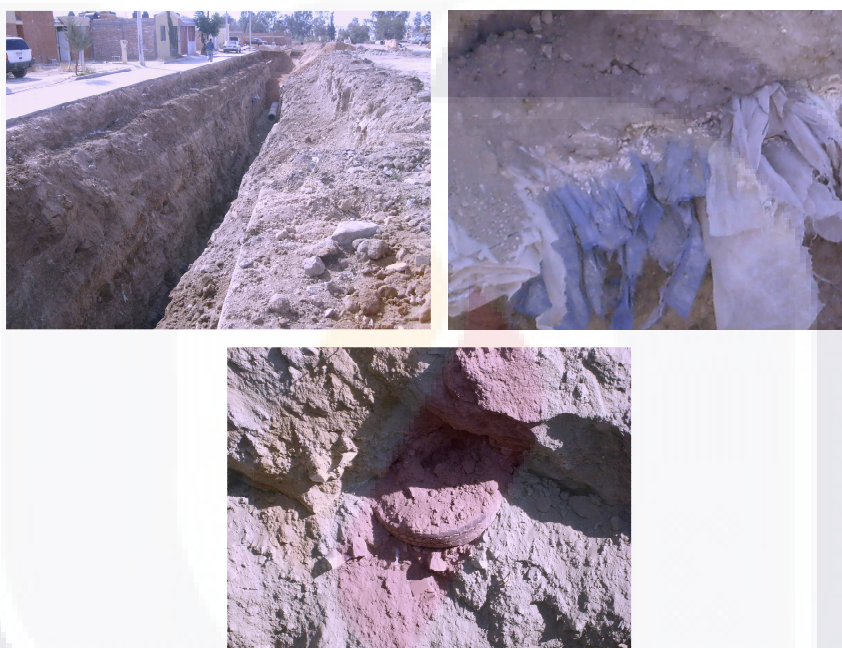
Figura 5.2. Rellenos sanitarios de gran espesor.
