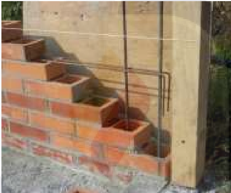
Figura 2.18. Refuerzo horizontal y vertical
