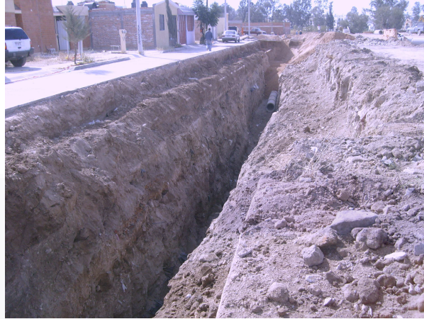
Figura 2.2 Viviendas sobre relleno sanitario
