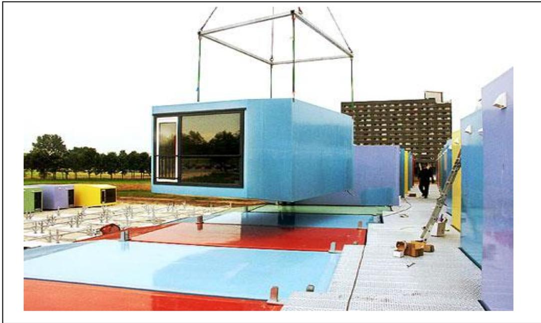
**Fig. 53 Montaje de una vivienda Container.**
