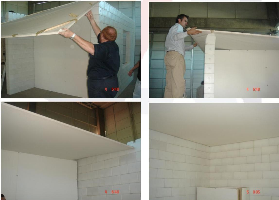
**Fig. 76 Colocación del plafón.**
