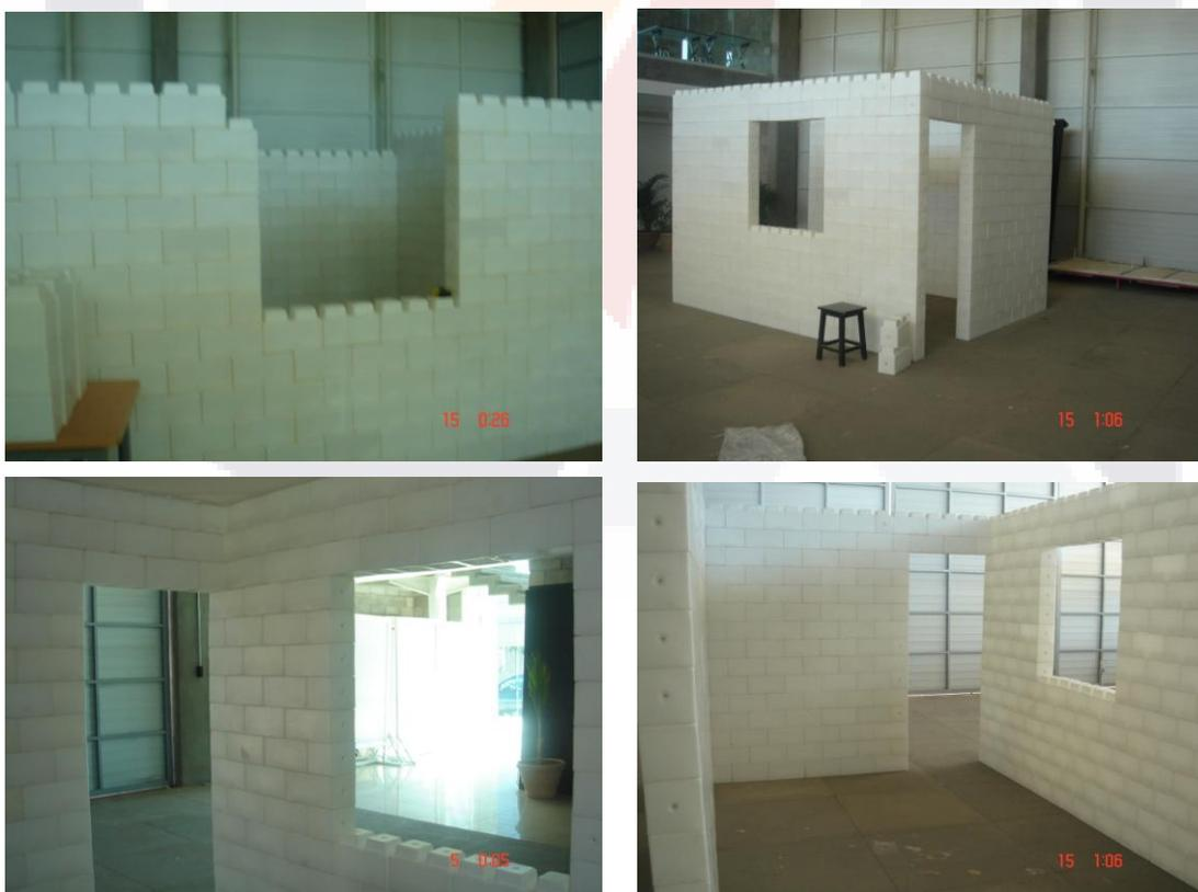
**Fig. 74. Construcción de ventana y puerta.**
