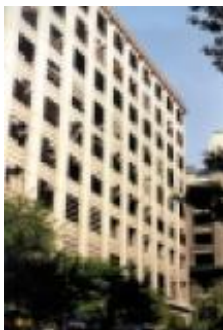
Fig.25.- Aleros en edificio
