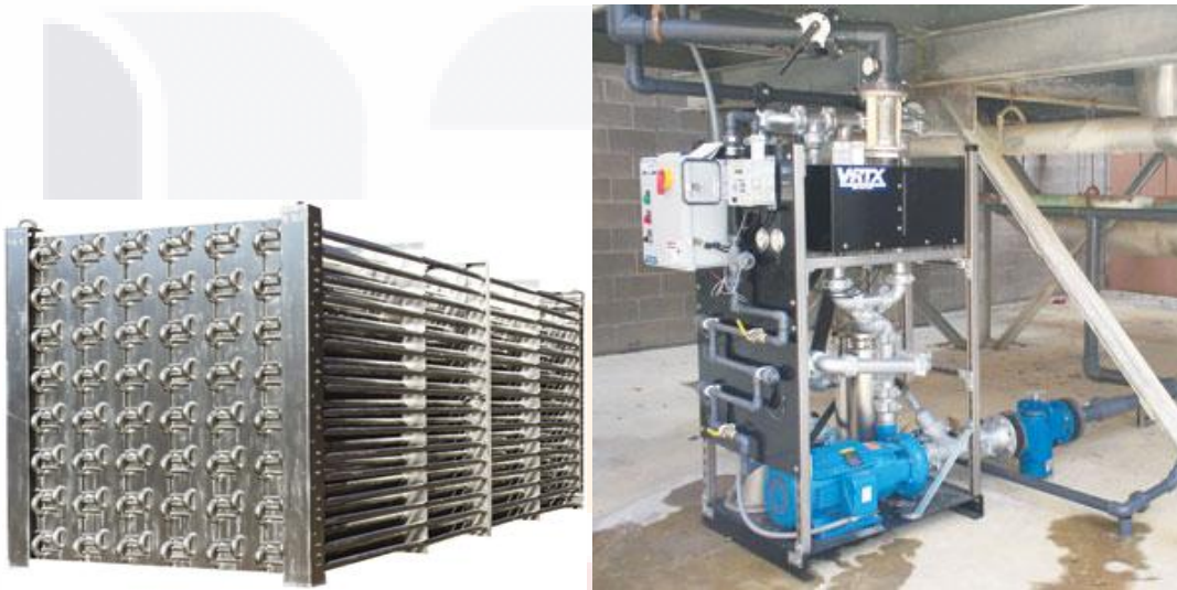
Fig. 62.- Sistema de serpentines para enfriamiento de agua dentro del edificio (Fuente Green Source Magazine).
