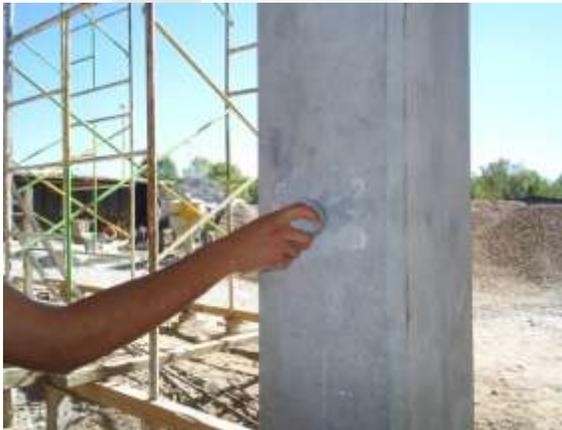
Figura 43. Limpieza de la superficie CCDC.
