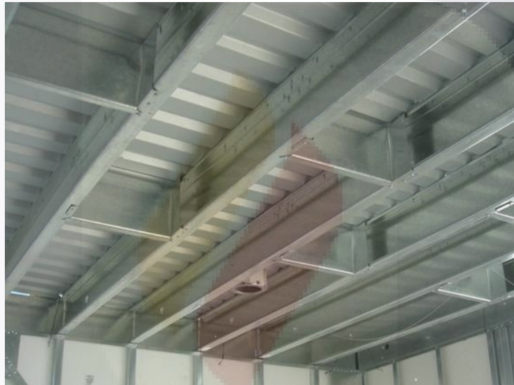
Figura 17.- Sistema de techo a base de paneles de azotea con lámina corrugada.
