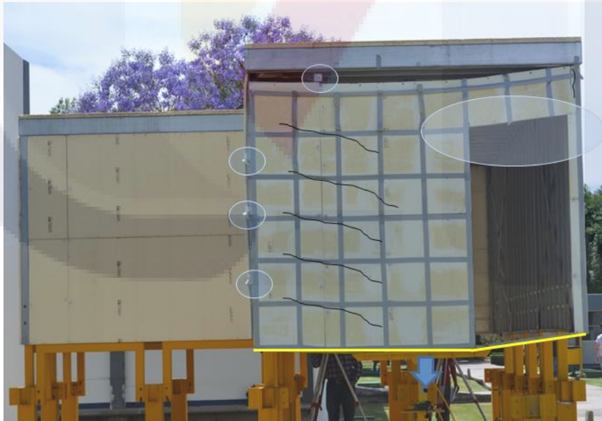
Figura 174.- Deformaciones máximas producidas en el muro norte de acuerdo con las mediciones topográficas realizadas durante la prueba experimental.
