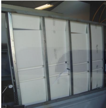
Figura 73.- Desarrollo de la prueba experimental donde se muestra la flexión de los studs y la fractura del poliestireno.
