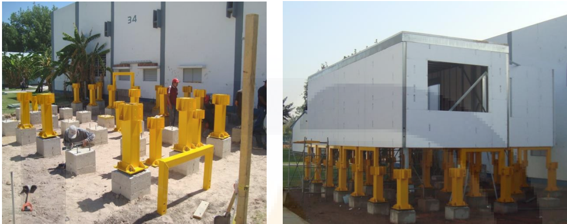
Figura 99.- Ensamble de la estructura metálica de la plataforma de simulación y montaje de la vivienda.
