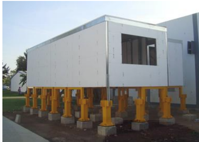
Figura 109.- Estructura de acero rolado en frío montada sobre plataforma de simulación de hundimientos diferenciales.
