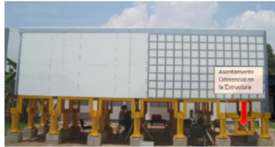
Figura 5. Prueba experimental ante asentamientos diferenciales en estructura a escala real. (Archivo personal).
