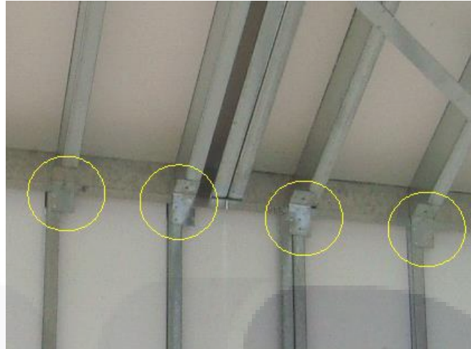
Figura 108.- Conectores en ángulo para uniones muro-losa.
