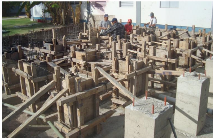
Figura 98.- Construcción de columnas de concreto reforzado para soporte de estructura metálica.
