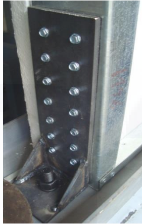
Figura 71.- Anclaje tipo "Hold Down"
