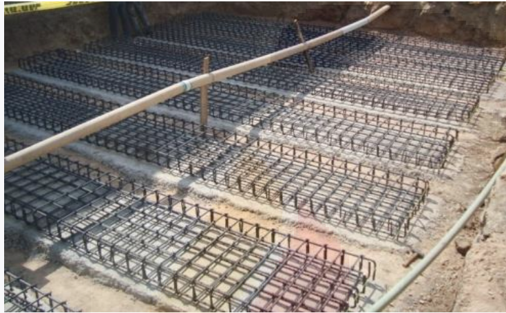
Figura 97.- Detalle del acero de refuerzo en zapatas de cimentación.
