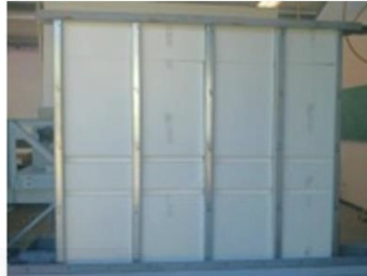
Figura 3. Marco de acero rolado en frío con recubrimiento de poliestireno expandido. (Archivo personal).
