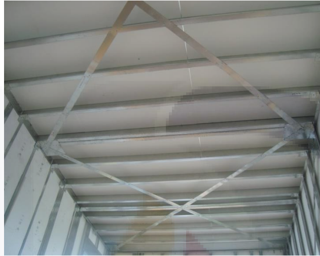
Figura 105.- Contraventeo superior en el sistema de losas.
