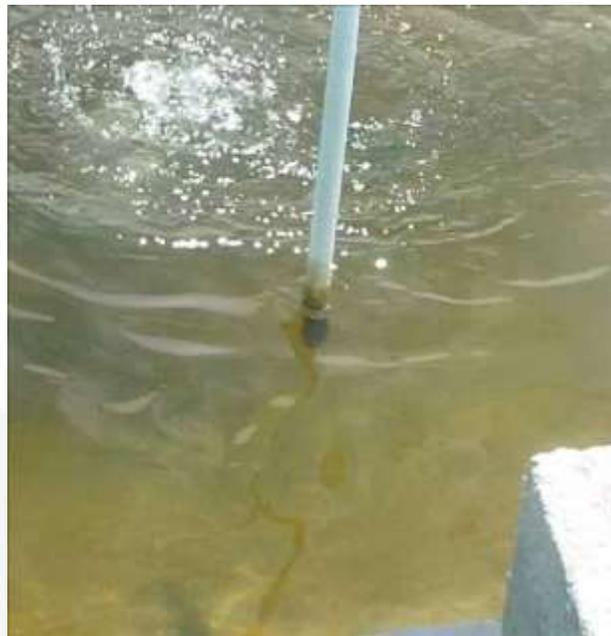
Figura 8. Tubo de succión del sistema semi-cerrado de recirculación.
