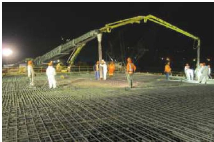
Figura 1.2.- Imagen del refuerzo convencional utilizado para un piso industrial (Fania construcción, 2015).
