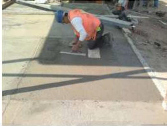
Figura 3-F.- Imagen de las losas con los ocho endurecedores y la losa de control.
