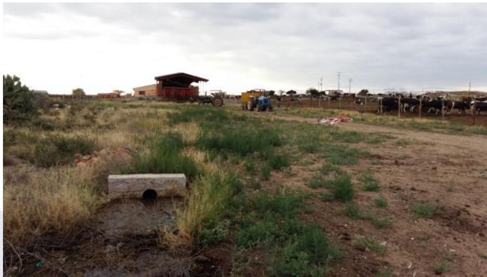
Figura No. 26. Descarga de la red sanitaria.
