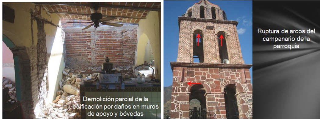
g) Demolición parcial de vivienda
