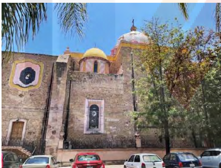
Figura 181: Sistema constructivo de cal y canto en los muros del templo del Señor del Encino
