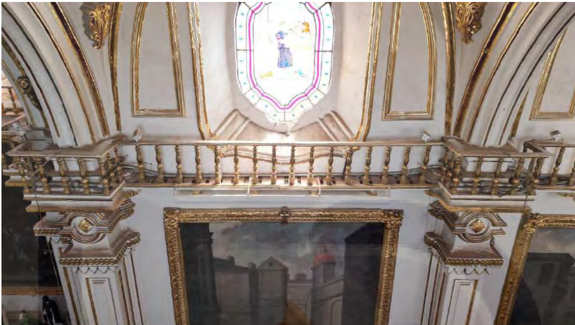
Figura 183: Capiteles de columnas, ménsulas y cornisa de cerramiento en la parte superior de la nave
