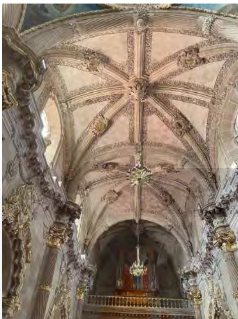
Figura 120: Interior del Santuario de Guadalupe donde se observan las bóvedas de pañuelo, el coro y las pilastras tritóstilas que sostienen las bóvedas. Imagen propia LEMM.
