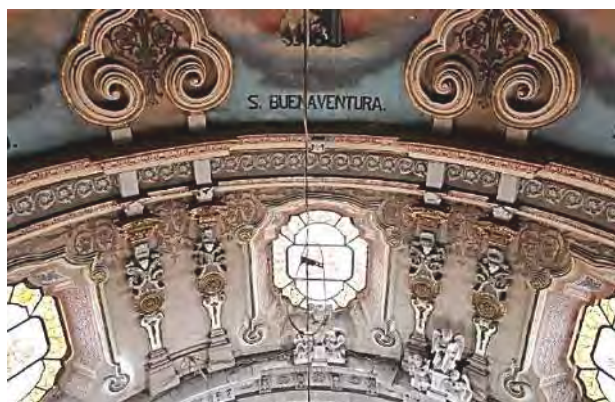
Figura 125: Vista del tambor de la cúpula, se observan las pilastras estípites que flanquean las ventanas que son polilobuladas, el entablamento que sostiene la cúpula decorada con pintura mural, de igual manera se observa la pintura en los paramentos del tambor. Imagen propia LEMM
