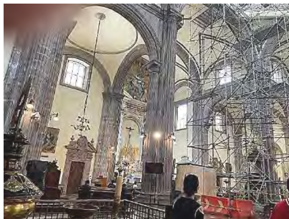
Figura 40: Interior del Sagrario Metropolitano, Imagen propia; LEMM tomada el 200824
