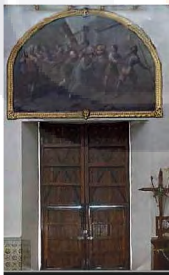
Figura 168: Acceso lateral al templo, en el lado oriente en el interior del templo, de forma rectangular. Imagen propia LEMM.
