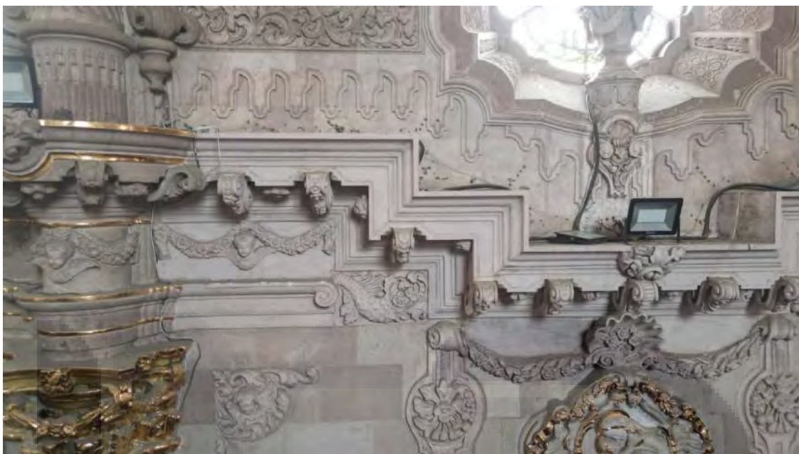
Figura 121: Molduras escalonadas que coronan la nave, con guardamalletas y borlas, el architrabe decorado con guirnaldas. Imagen propia IISS/LEMM
