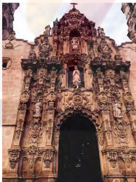
Figura 17: Imagen del estado actual de la portada del Santuario de Guadalupe en Aguascalientes, imagen propia LEMM
