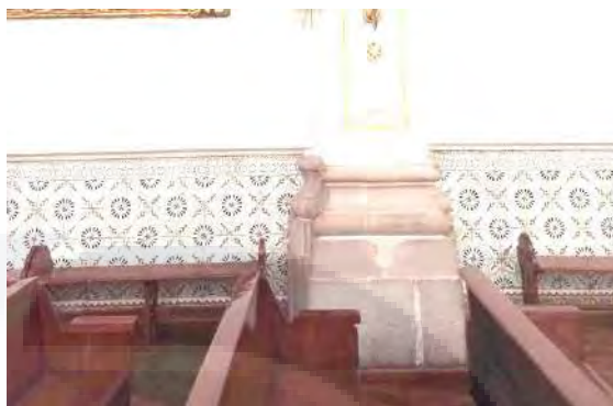
Figura 167: Guardapolvos perimetral de azulejo de talavera y basamentos de cantera, columnas entabladas. Imagen propia LEMM
