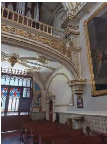
Figura 164: El acceso del templo se encuentra en el sotocoro, ahí se ubica un cancel de madera o Nártex con dos puertas laterales y una central, bajo el cubo de la torre está el baptisterio, en la imagen se aprecia el acceso al mismo. Imagen propia LEMM
