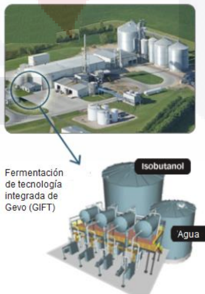
Figura 8. Planta de producción de isobutanol Gevo. (Modificado del sitio oficial de la empresa, Octubre 2012).
