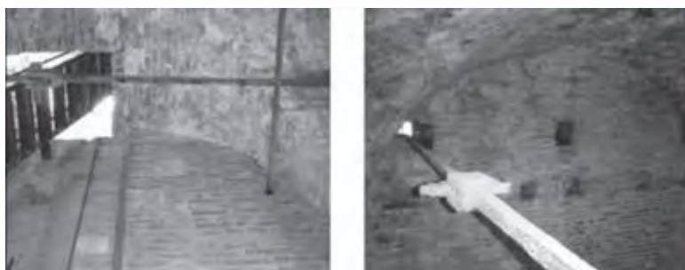
Figura 1 Rejas metálicas en la parte superior interna de la “Torre Grossa” en San Gimignano (Preciado, et al, 2015).
