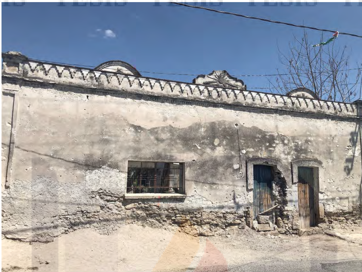
Figura 43. Casa de Huatlatlauca, construida con adobe, piedra y vigería de madera.
