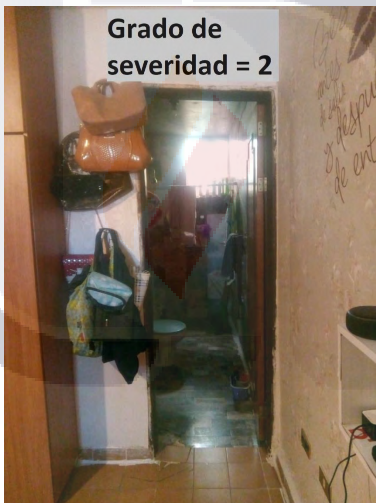
Figura 32. Descuadre de puerta ubicada entre el dormitorio 1 y baño 1.
