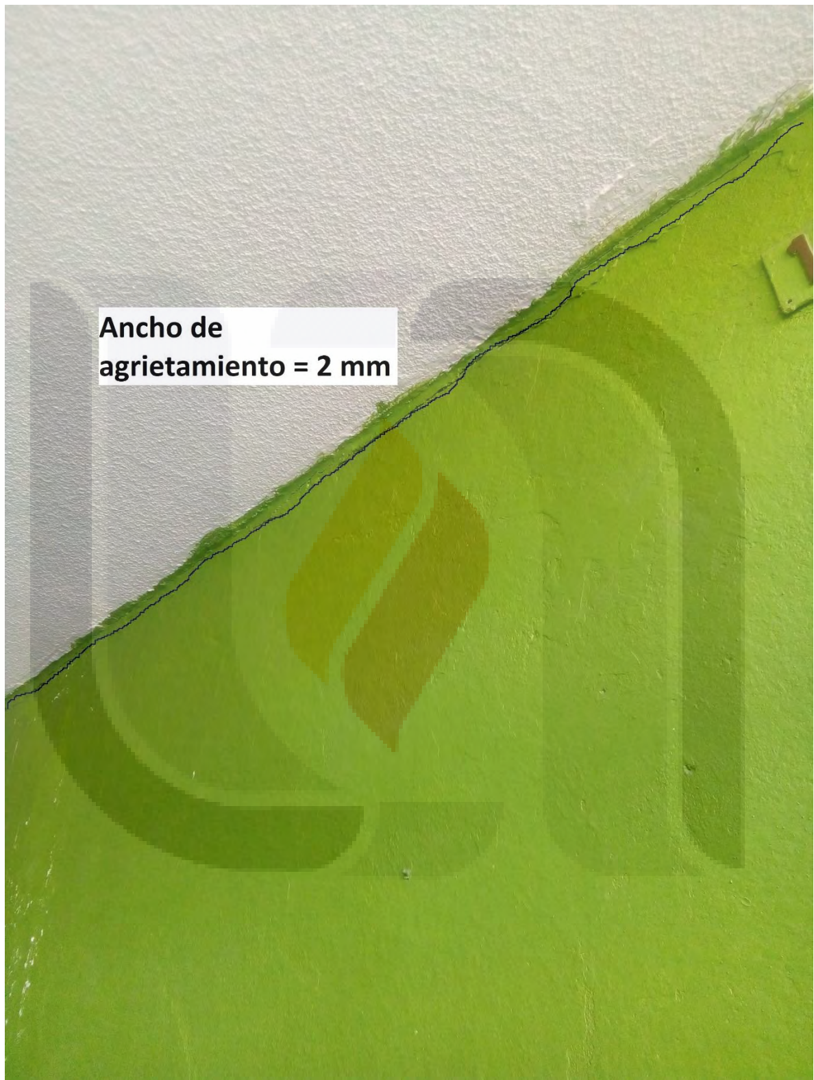
Figura 24. Agrietamiento en muro paralelo a la losa en el eje longitudinal I, ubicado en la cochera. Este agrietamiento destaca por tener el mayor espesor de los agrietamientos de esta subcategoría.
