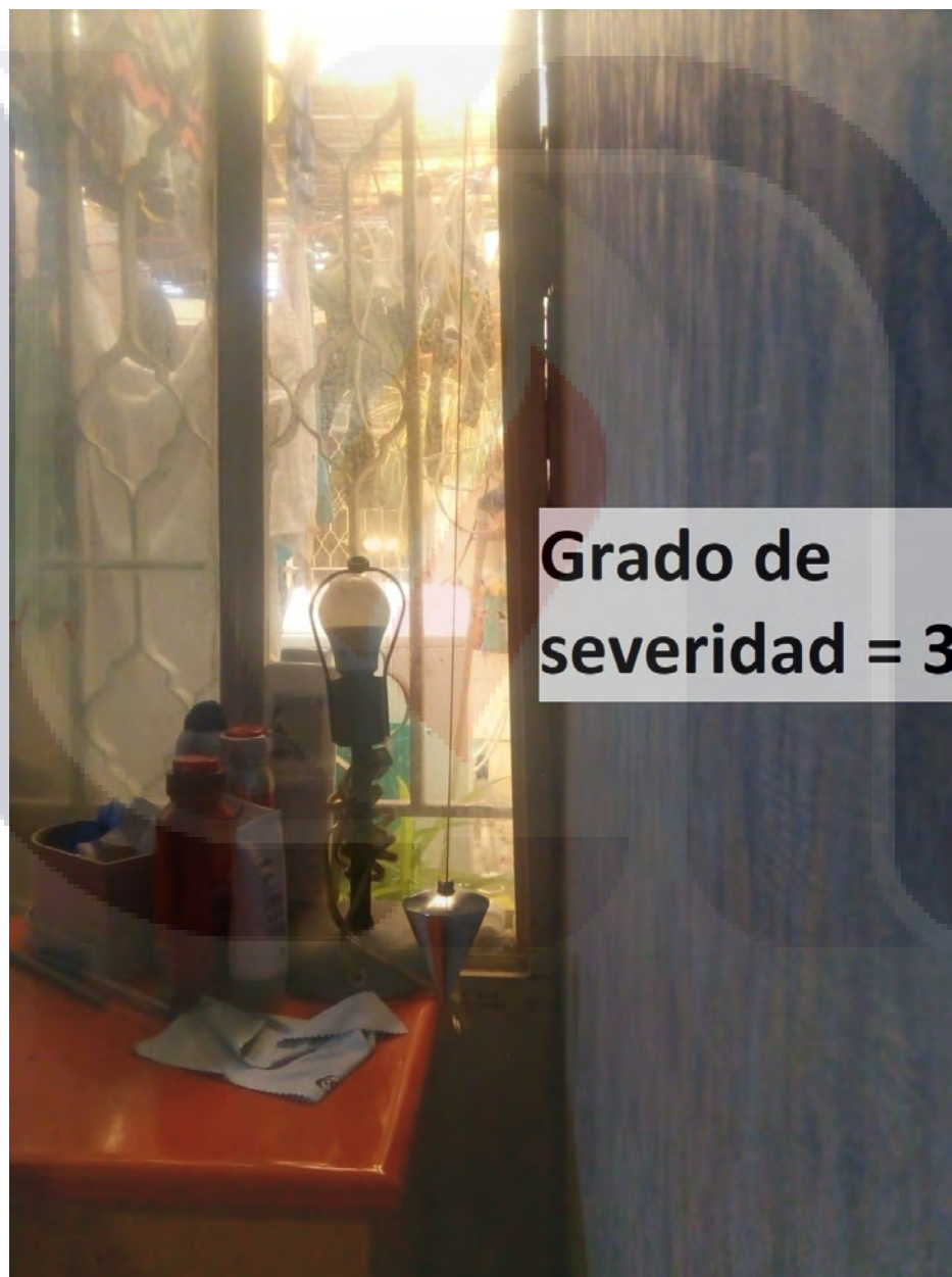
Figura 31. Desplome de muro sobre el eje longitudinal A, ubicado en el dormitorio 2.
