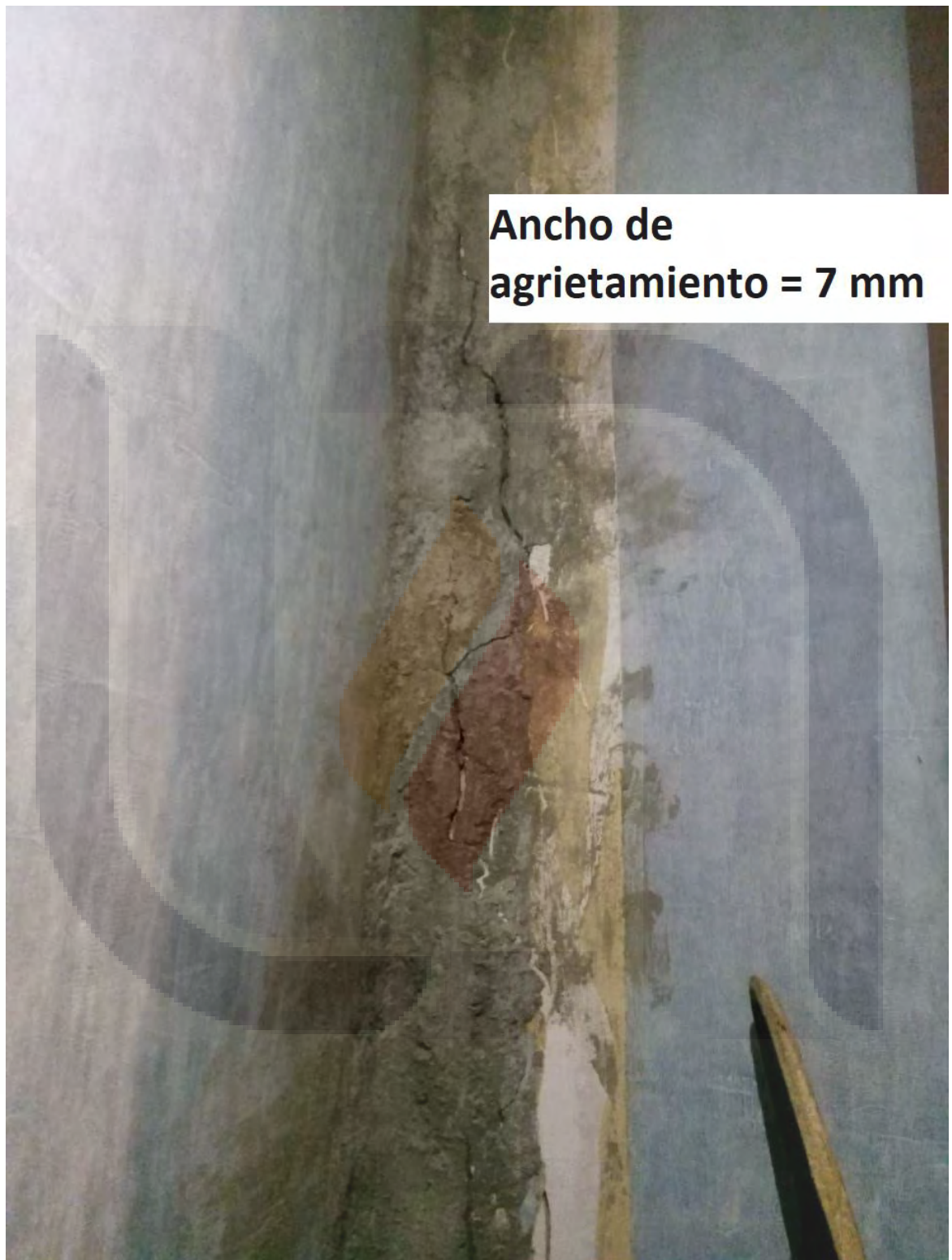
Figura 23. Agrietamiento de muro paralelo al castillo en la intersección entre el ejes 6 transversal y A longitudinal, ubicada en el dormitorio 2. Este agrietamiento destaca por su gran espesor.
