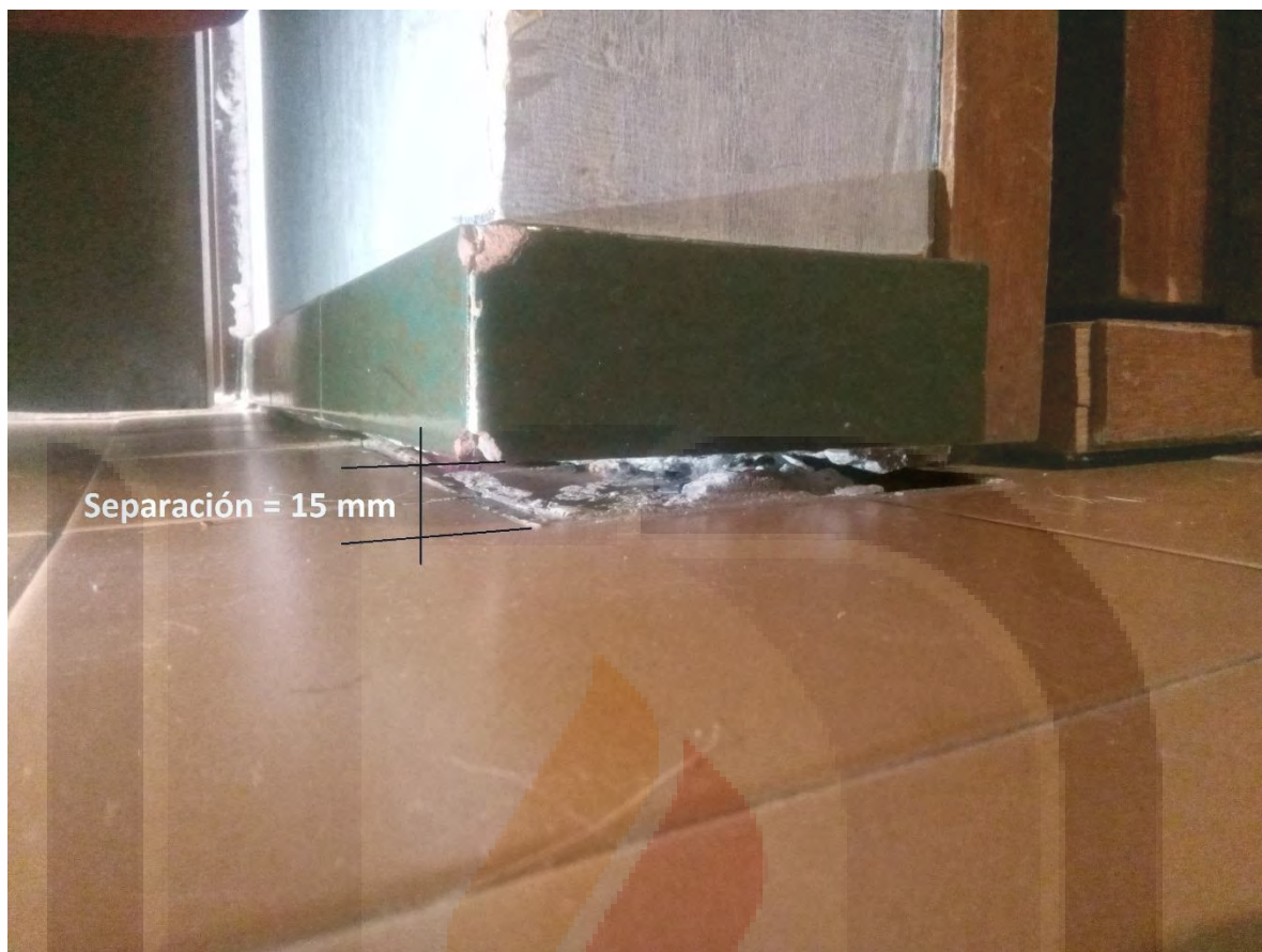
Figura 22. Agrietamiento de muro paralelo al suelo en la intersección entre el ejes 2 transversal y D longitudinal, ubicada en el dormitorio 2. Este agrietamiento destaca principalmente por su espesor y porque la dirección de la separación entre el muro y suelo es vertical.
