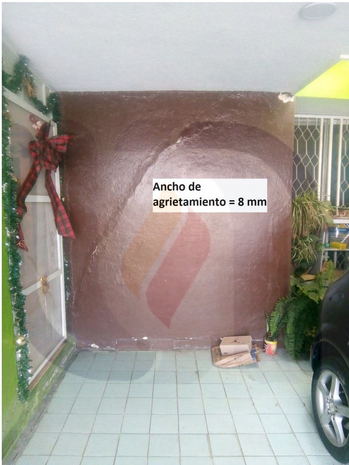
Figura 21. Agrietamiento de muro sin considerar los bordes sobre eje 9 transversal, ubicada en la cochera. Este agrietamiento destaca por su traza curva prominente.
