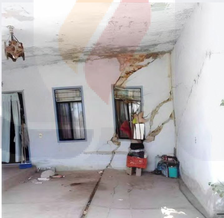
Figura 1. Ejemplo de vivienda dañada por subsidencia diferencial, ubicada en la localidad de Pabellón de Hidalgo, Aguascalientes (México).
