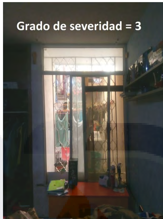
Figura 33. Descuadre de ventana ubicado entre el dormitorio 2 y el patio.
