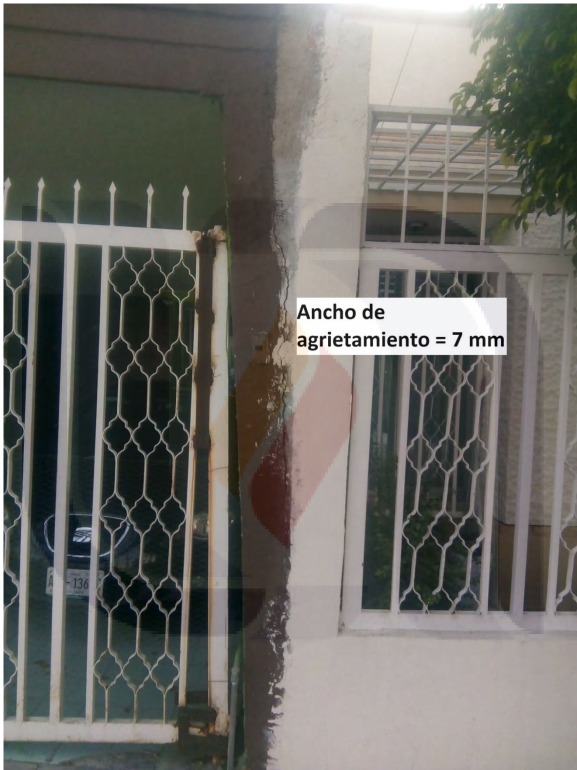
Figura 25. Agrietamiento vertical por separación entre predios sobre el eje longitudinal I, en la colindancia derecha de la vivienda estudiada. Este agrietamiento destaca por tener el mayor espesor de los agrietamientos de esta subcategoría.
