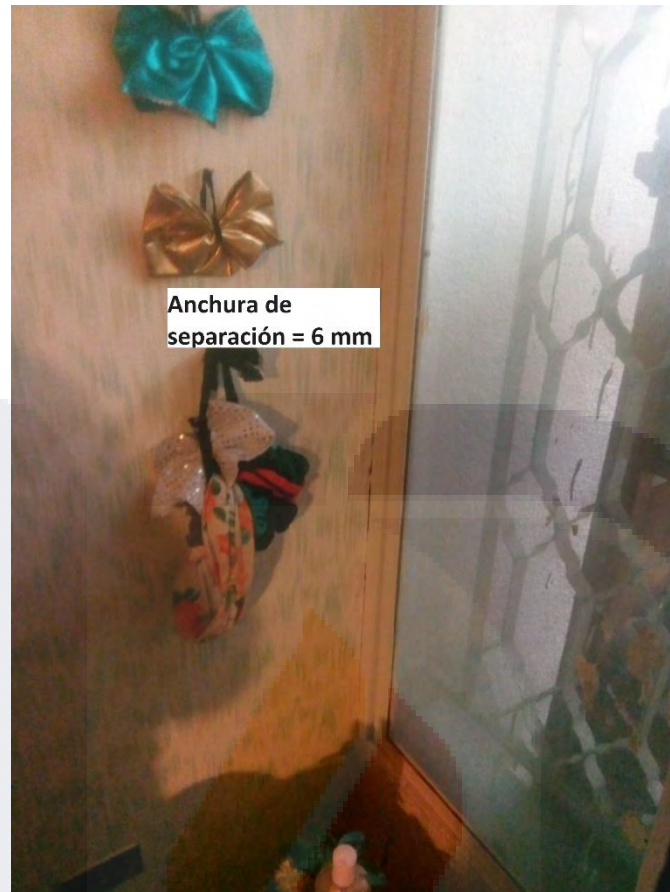
Figura 35. Desprendimiento de herrería de marco ventana ubicado entre el dormitorio 3 y la sala de estar 2. Este desprendimiento destaca por ser el uno de los registros con mayor espesor registrados de esta subcategoría.
