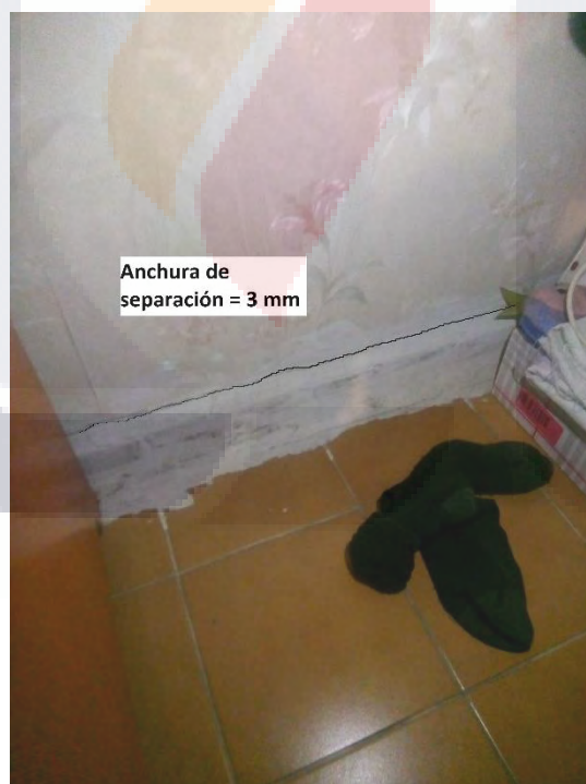
Figura 37. Desprendimiento de zoclo sobre el eje longitudinal I, ubicado en el dormitorio 1. Este desprendimiento destaca por ser el uno de los registros con mayor espesor registrados de esta subcategoría.
