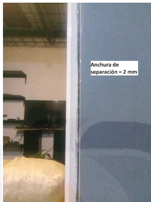
Figura 36. Desprendimiento de herrería de marco de abertura ubicado entre el pasillo y la sala de estar 2. Este desprendimiento destaca por ser el uno de los registros con mayor espesor registrados de esta subcategoría.
