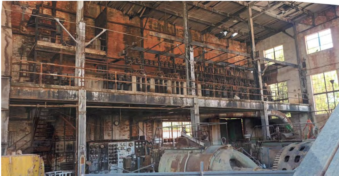
Imagen 39.- Cuarto de máquinas de la antigua planta de generación de energía. Autoría propia, 2024.
