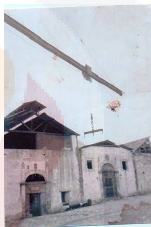
Cambio de techumbre fábrica de azúcar y bodegas.
