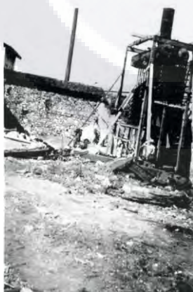
Apuntalamiento o desembalaje de equipo industrial, al fondo, barda perimetral y chacuaco metálico.
