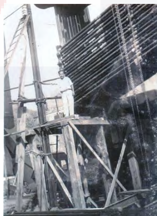
Apuntalamiento de columna metálica.
