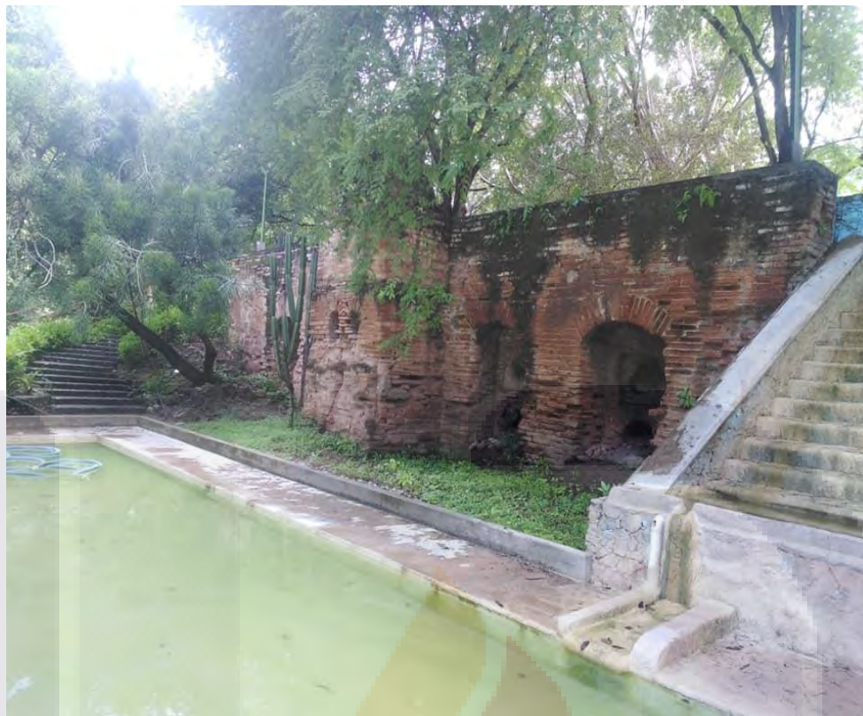
Chimenea y hornallas de la casa de calderas de la ex hacienda de Quenchendio, mpio. de Huetamo, Mich.
