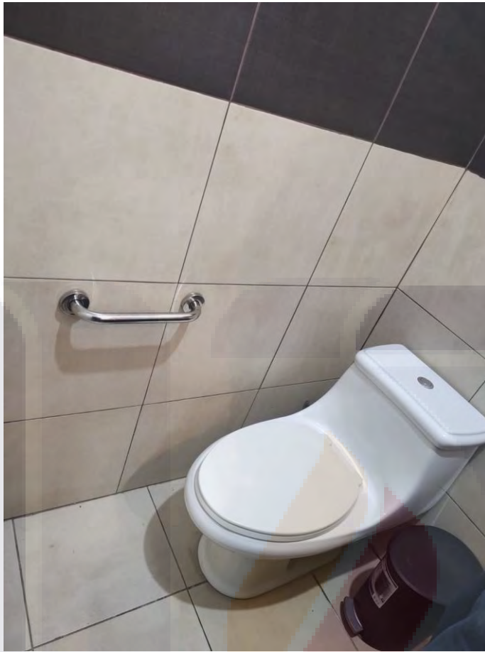
Ilustración 12 Fotografía del Baño de la Empresa ABC Una Vez Instalada la Barra de Soporte
