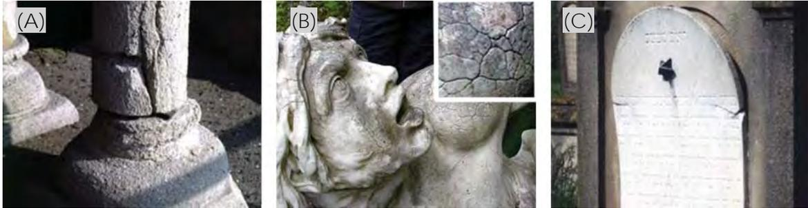
Ilustración 20 Grietas y deformaciones: (A) Grietas (B) Craquelado (C) Pandeo (ICOMOS, 2008)
