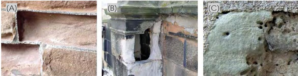
Ilustración 22 (A) Alveolos o cavidad, (B) segmento perdido, (C) perforaciones (ICOMOS, 2008)
