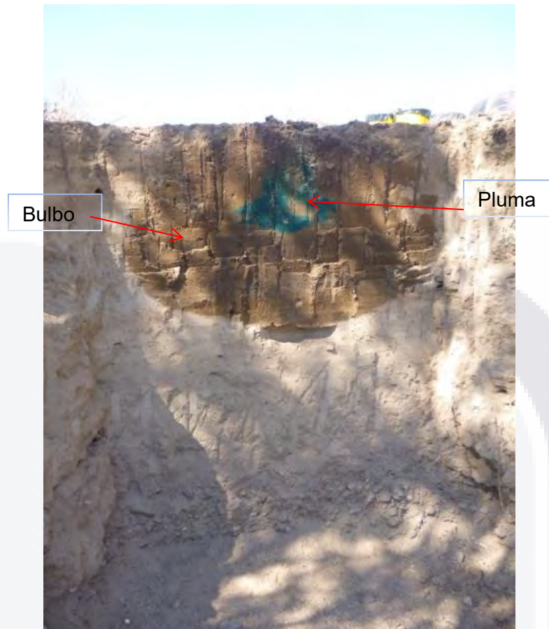
Figura 3.17 Corte del perfil de infiltración
