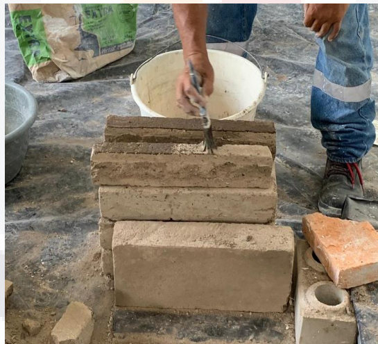
Figura 62: Mojado de ladrillos de adobe con mucílago para su correcta colocación y adherencia. Imagen del autor.
