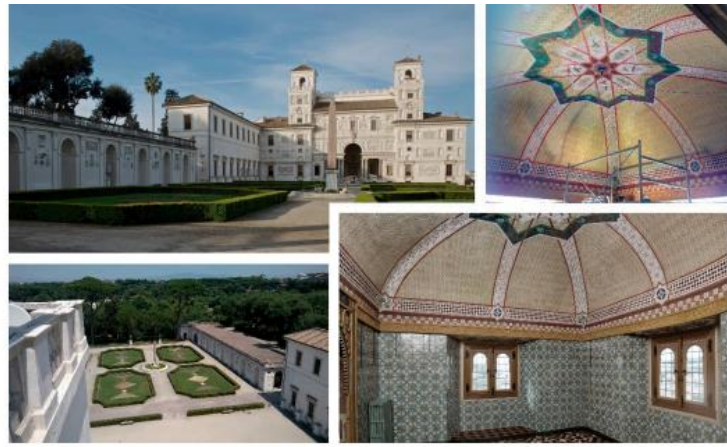
Figura 8: Daño por humedad en Sala Turca de la Villa Medici en Roma (Barone & Ferrara, 2018).
