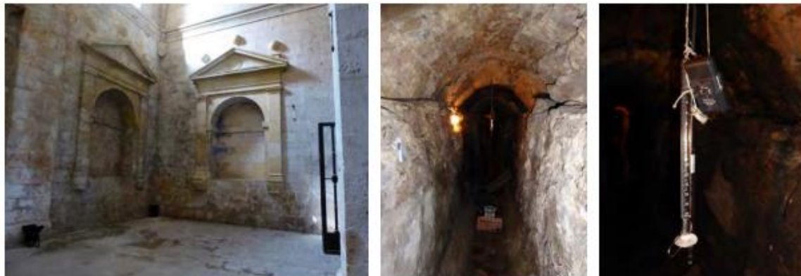
Figura 4: Monitorización de la cámara de Drenaje-Aireación de la Iglesia de Santa Cruz la Real de Segovia (Gil Muñoz & Lasheras Merino, 2018).
