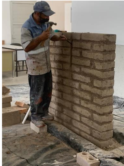
Figura 54: Corte con disco en muro de adobe para la colocación de tubería de PVC. Imagen del autor.
