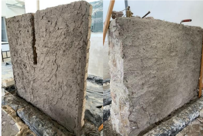
Figura 61: Repellado en muros. Imagen del autor.
