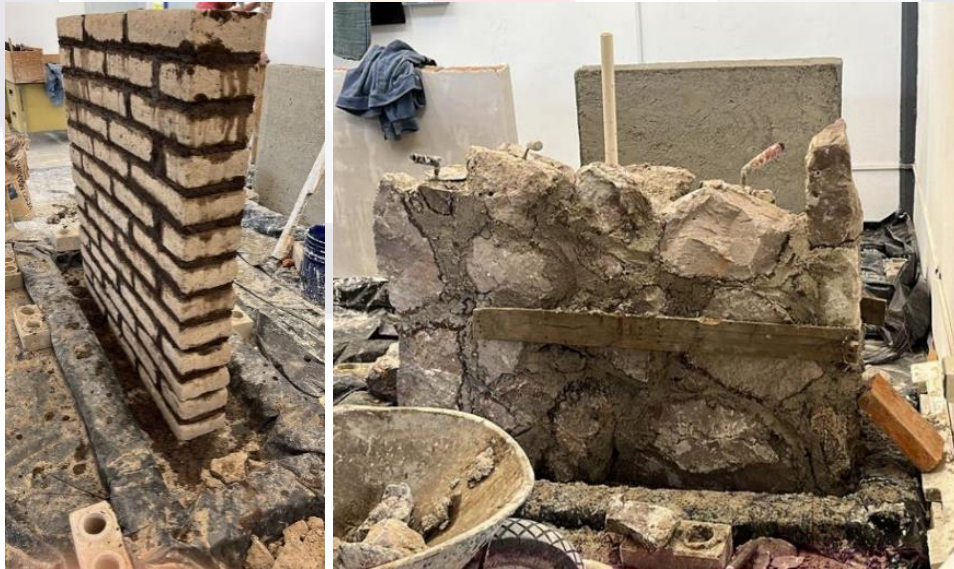
Figura 53: Construcción de muros: (Izq) Muro de Adobe, (Der) Muro de mampostería de piedra. Imagen del Autor.
