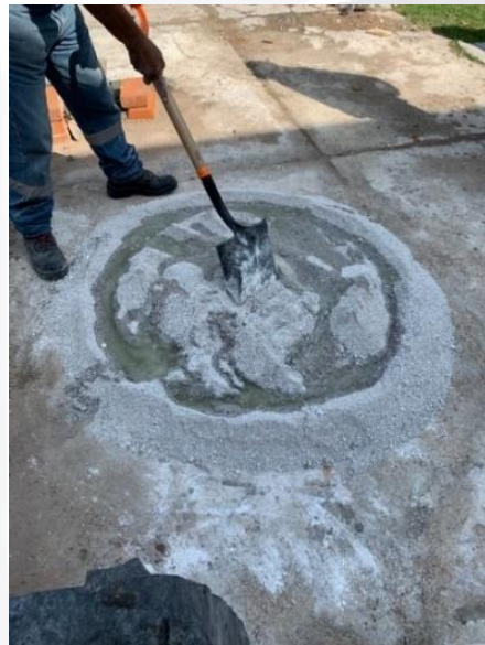
Figura 60: Mezcla para recubrimiento con proporcionamiento adecuado. Imagen del autor.
