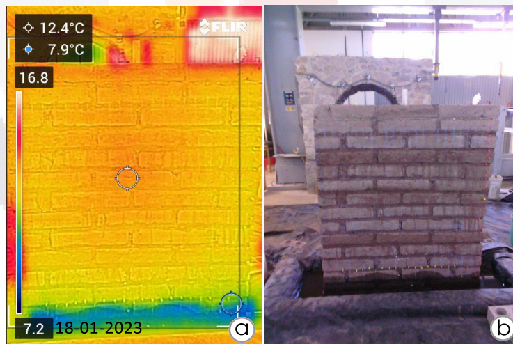
Figura 87: Imágenes de termografía infrarroja. Humedad por capilaridad en muro de adobe sin recubrimiento. Procesamiento en software Flir Tools. Imagen del autor.
