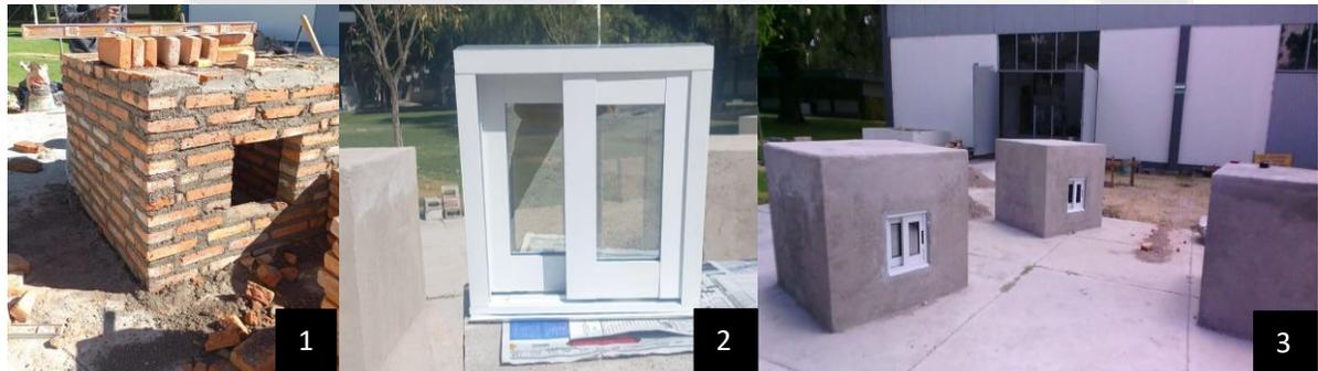
Figura 9. Proceso constructivo cubos probeta. Elaboración propia
