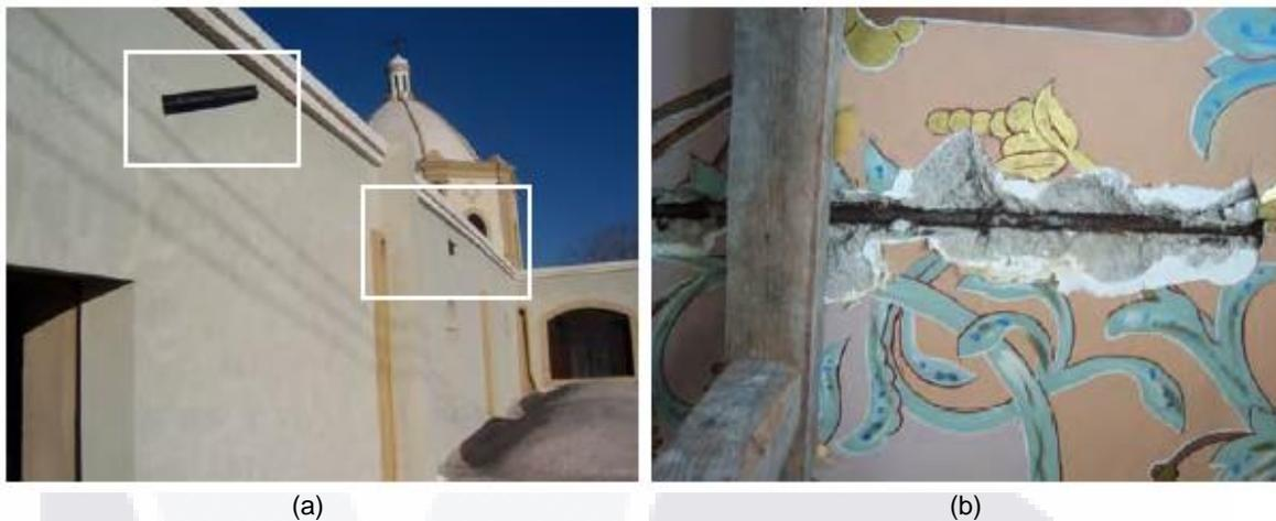
Figura 9 (a) En los recuadros interiores, anclajes de los tensores transversales adosado a las bóvedas. (b) Detalle del tensor correspondiente a la bóveda del coro (Araiza 2009).
