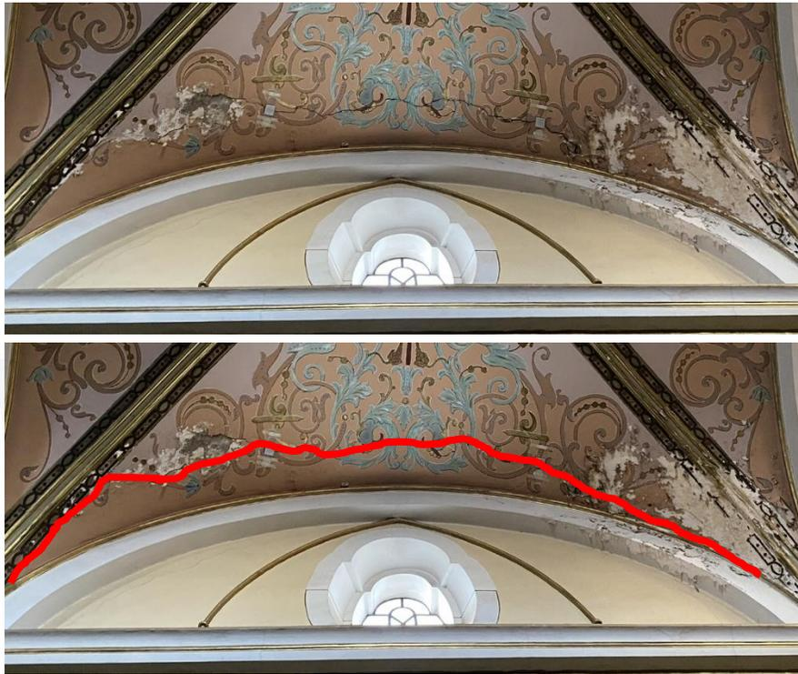
*Figura 35 Grieta existente en bóveda intermedia de nave principal.*
