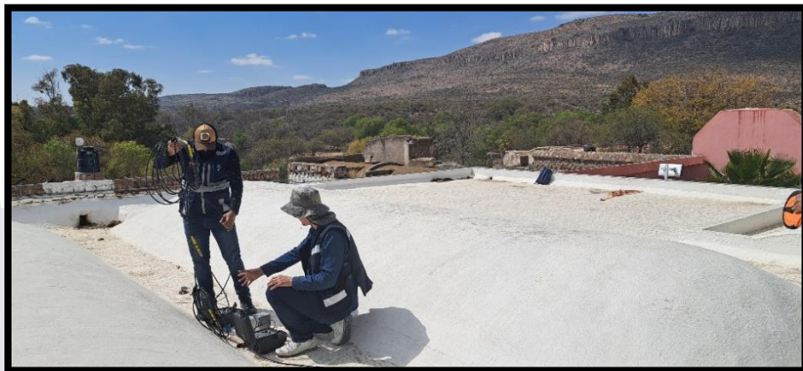
Figura 29. Mediciones de vibración ambiental sobre el punto 2
