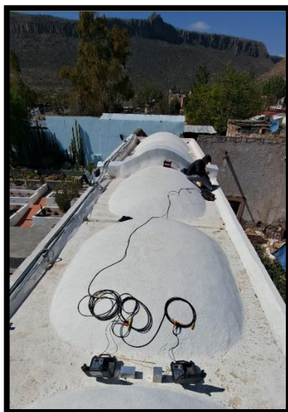
Figura 32. Mediciones de vibración ambiental sobre el punto 5
