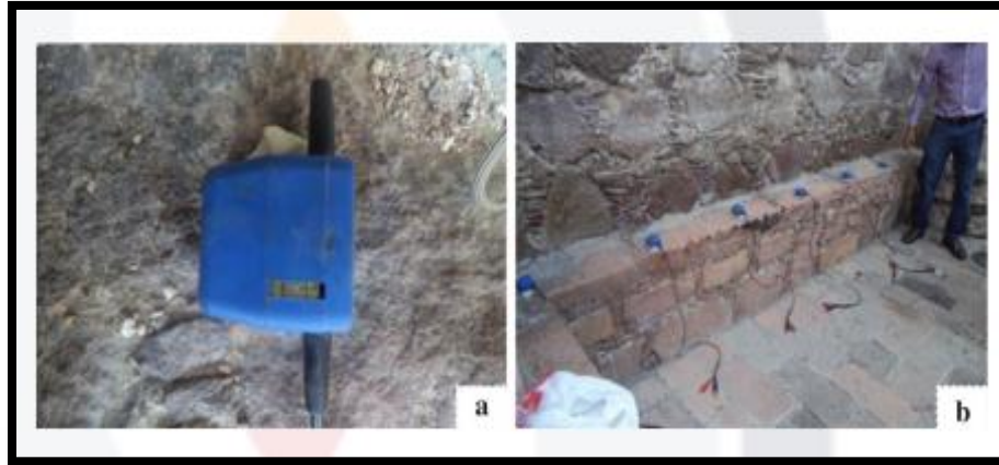
Figura 2. Colocación de geófonos en mampostería. Orenday T. (2018)
