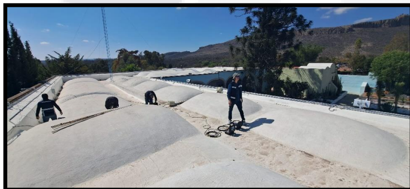
Figura 31. Mediciones de vibración ambiental sobre el punto 4.
