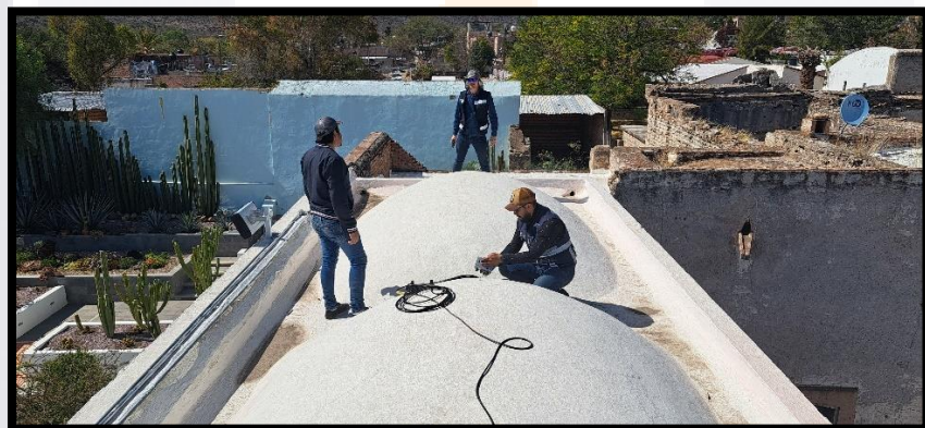
Figura 33. Mediciones de vibración ambiental sobre el punto 6
