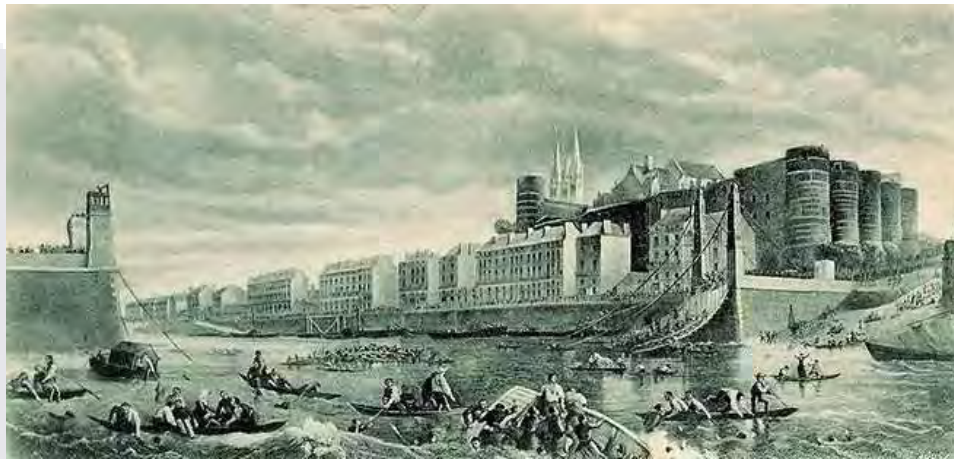
Fig. 2 – Colapso del puente de Angers. Fuente: Fernández, 2014, Sin nombre [Foto], recuperado de https://www.patologiasconstruccion.net/2014/04/colapsos-estructurales-historicos-parte-5-ano-1850/
