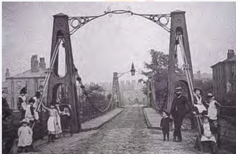
Fig. 1 – Puente suspendido de Broughton. Fuente: Fernández, 2014, Sin nombre [Foto], recuperado de https://www.patologiasconstruccion.net/2014/01/colapsos-estructurales-historicos-parte-3-del-ano-1500-al-1831/
