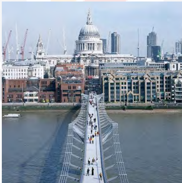
Fig. 4 – Vista Aérea del Millenium Brigde. Fuente: Foster&Partners, Sin nombre [Fotografía], recuperada de https://www.fosterandpartners.com/projects/millennium-bridge
