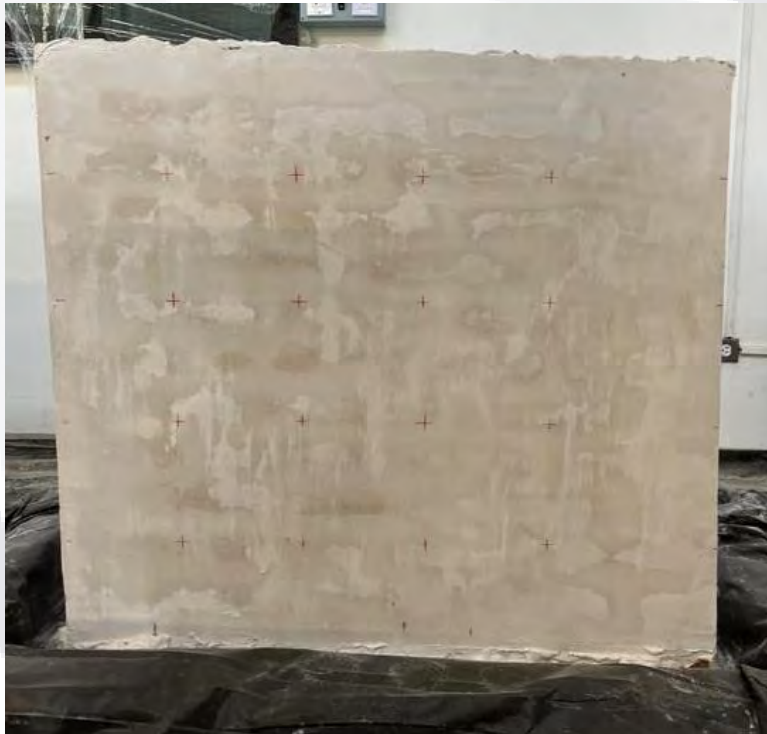
Ilustración 45 Muro 3, Lado A. Imagen del autor.
