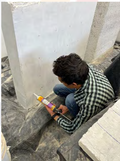
Ilustración 60 Aplicación de Sikamur InjectoCream-100. Imagen del autor.
