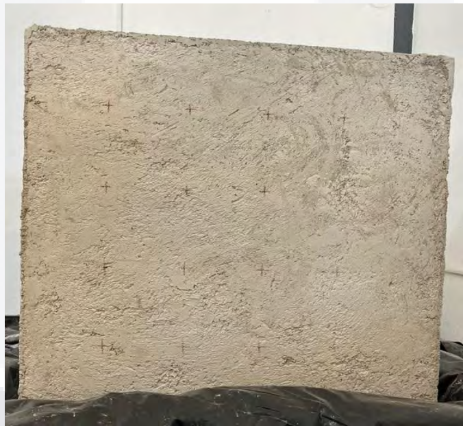
Ilustración 47 Muro 4, Lado A. Imagen del autor.
