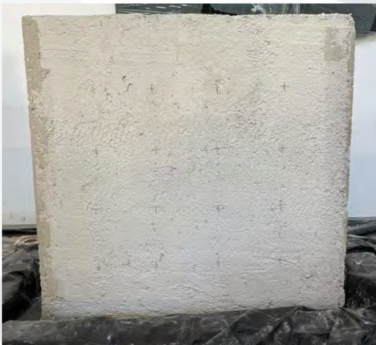
Ilustración 43 Muro 2, Lado A. Imagen del autor.
