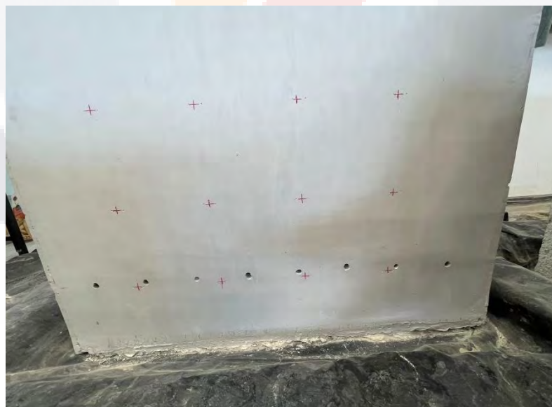
Ilustración 59 Orificios en muro a cada 12 cm. Imagen del autor.
