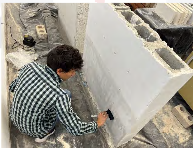
Ilustración 63 Aplicación de Sika Zero Salitre. Imagen del autor.
