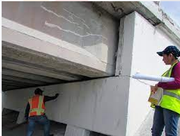
Ilustración 2 Inspección visual de elementos de un puente. Imagen del autor.
