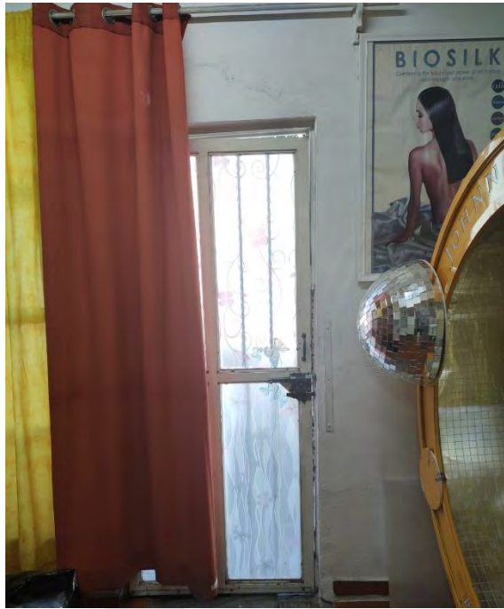
Figura 3. 7 Puerta de la entrada desalineada con marco (Fuente propia).
